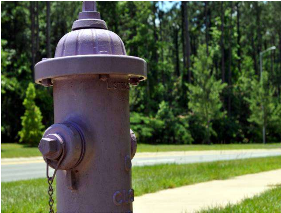
Fotografía 20.- En Florida, los hidrantes morados proveen agua regenerada para la operación del departamento de bomberos.
