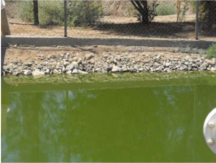
Fotografía 3.- Aspecto del afluente que ingresa a Planta Zaragoza, Mexicali, B.C.
