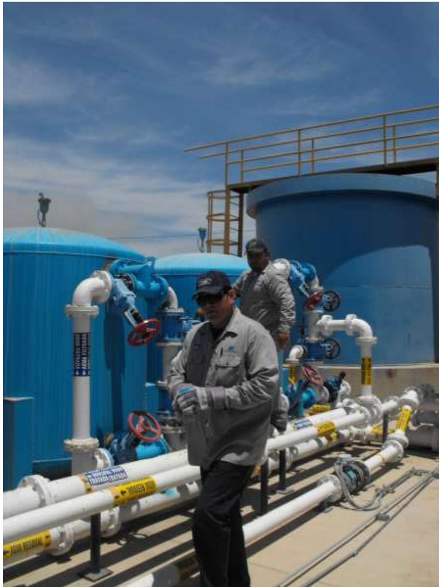
Fotografía 7.- Operador realizando lavado de tanques en Planta Zaragoza, Mexicali, B.C.
