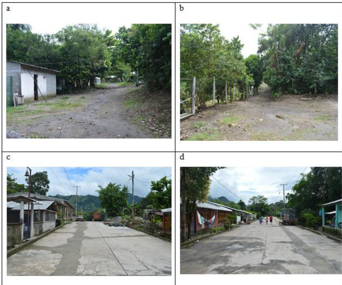
Figura 16. Las fotografías a y b corresponden a los caminos de terracería en la zona. Las fotografías c y d corresponden a los caminos pavimentados dentro de la zona.
