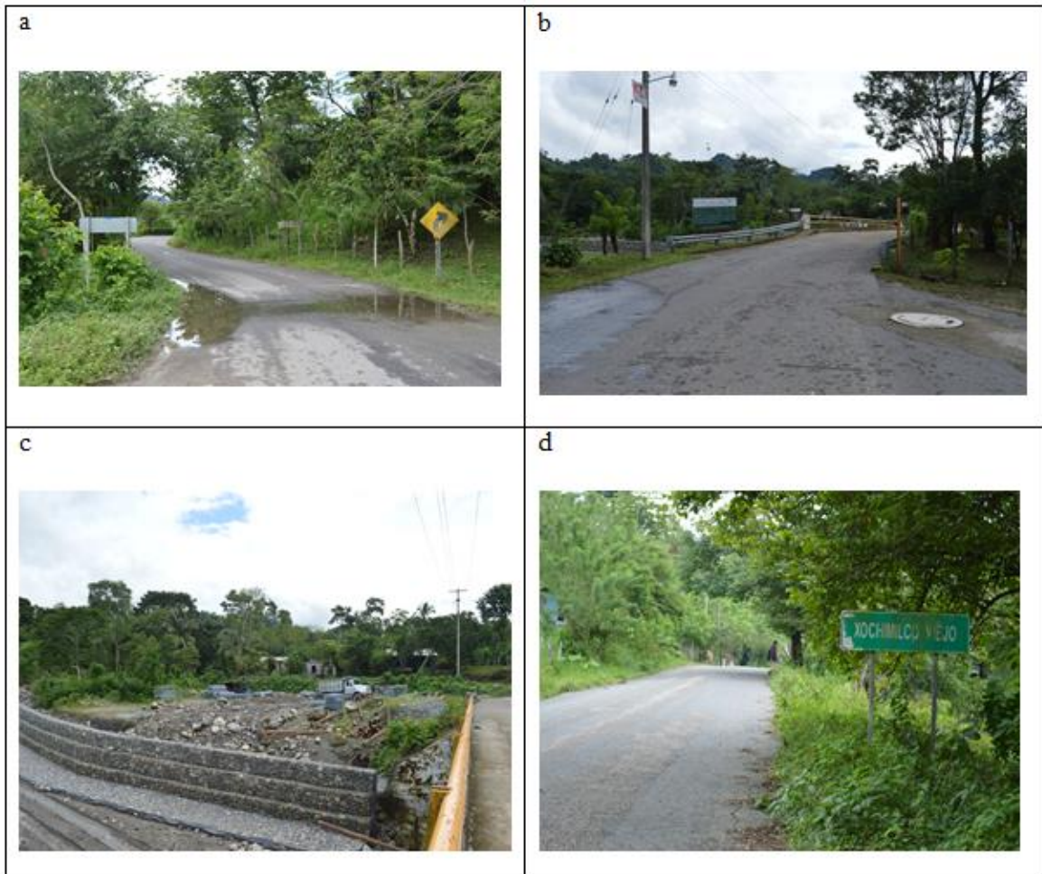
Figura 15. Las fotografías a y b corresponden a los caminos de terracería. Las fotografías c y d corresponden a caminos pavimentados dentro de la misma comunidad.
