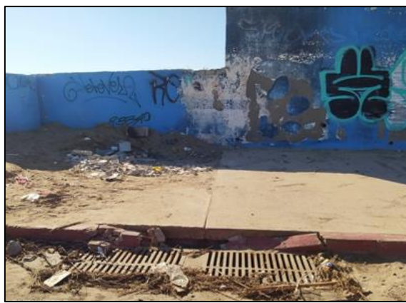
Fotografía 6. Infraestructura vandalizada 1 – Cárcamo de bombeo
