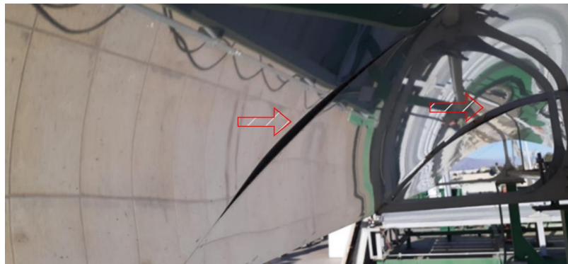
Figura 66. Receptor del sistema colectores cilindro parabólicos.
