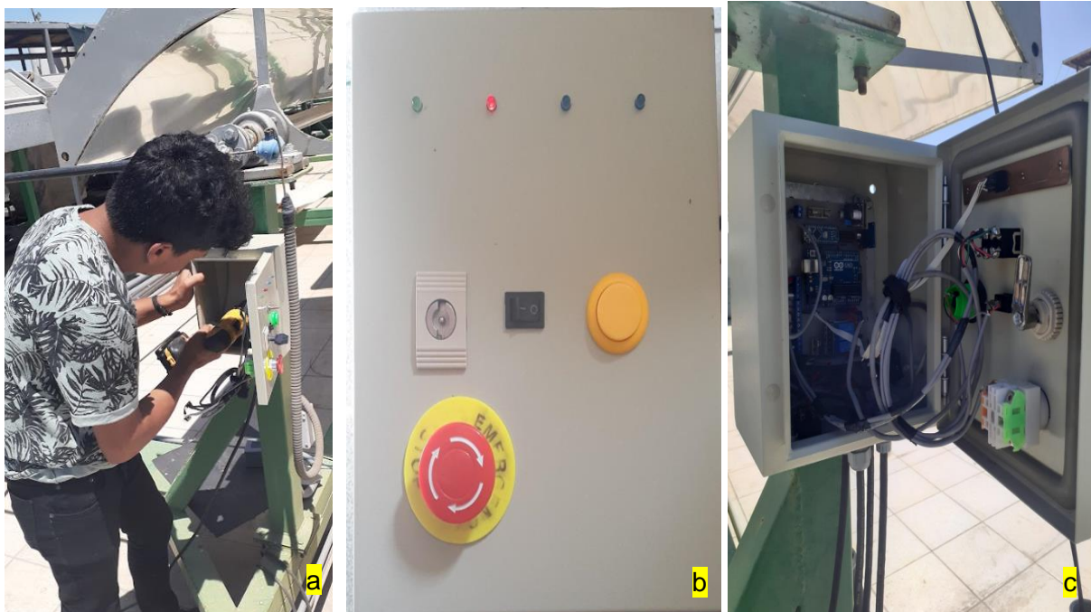
Figura 79. Montaje del módulo de seguimiento en el sistema CCP.
