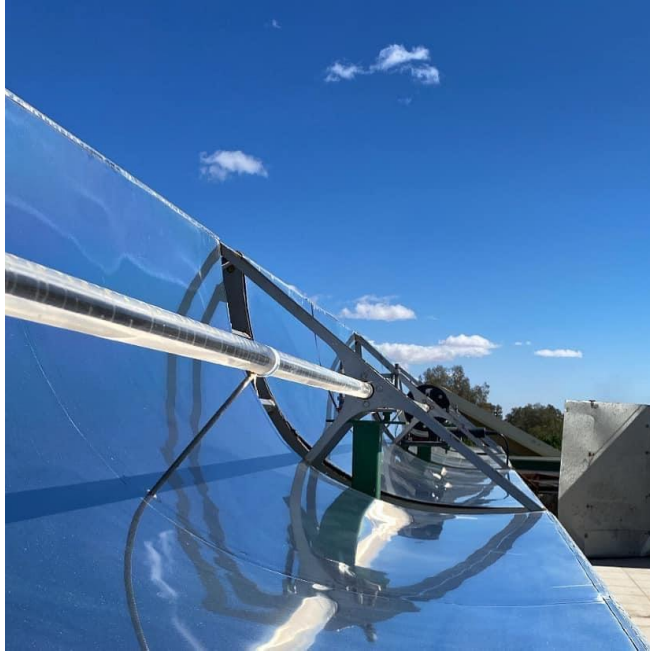
Figura 81. Concentración de los cilindro parabólicos durante el equinoccio de primavera.
