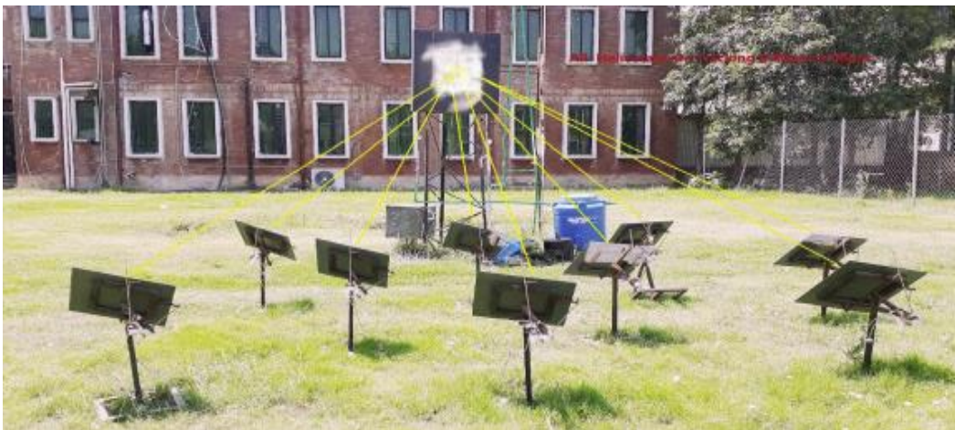
Figura 5. Seguidor solar de foco fijo.
