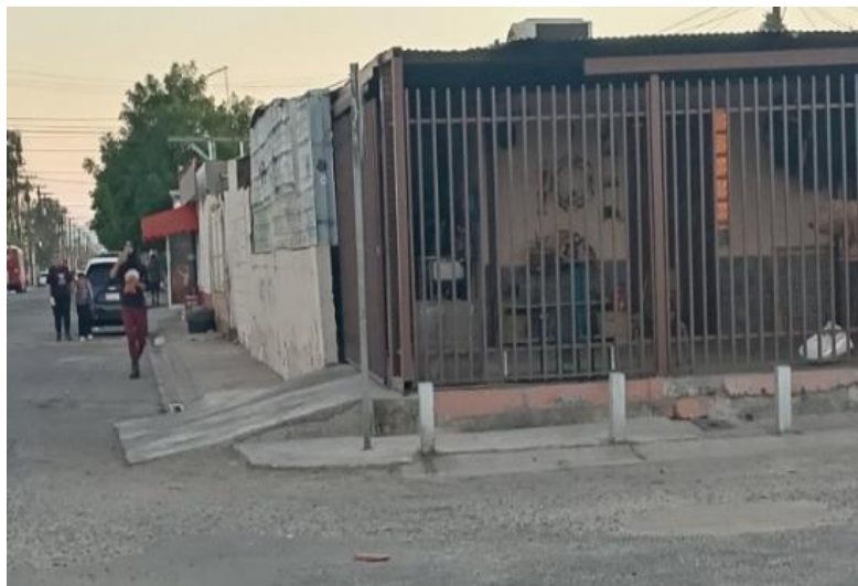
Figura 37 Adecuaciones de viviendas que obstruyen el libre tránsito
