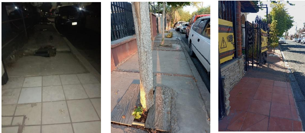
Figura 24 Banqueta en la colonia independencia con adecuaciones y daños sobre la banqueta
