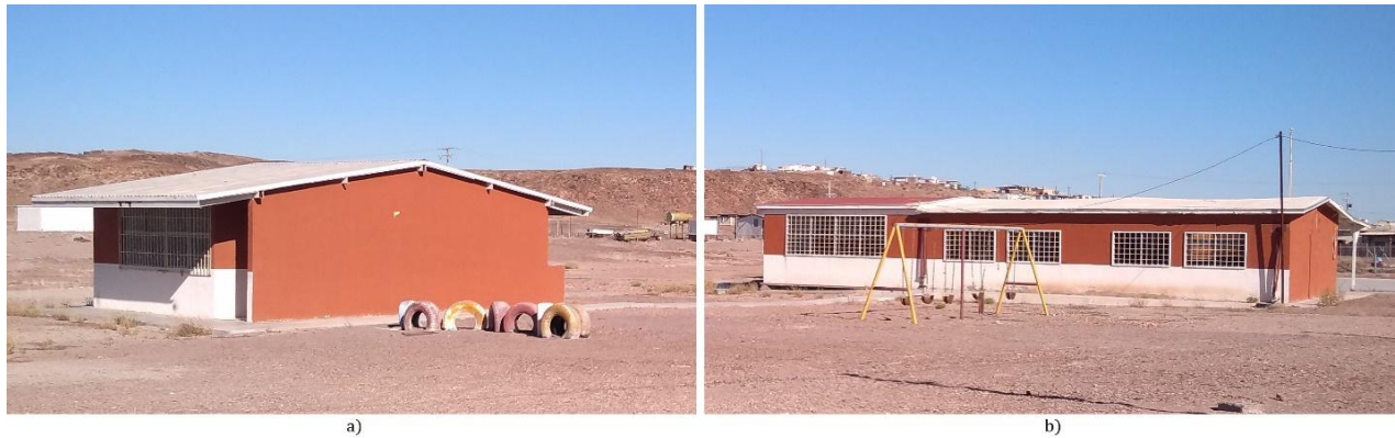
Figura 40. Aulas de la escuela de Puertecitos.
