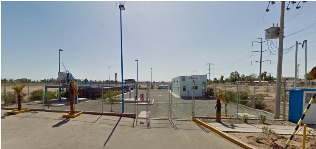
Figura 3. Vista de la PTAR CETYS
