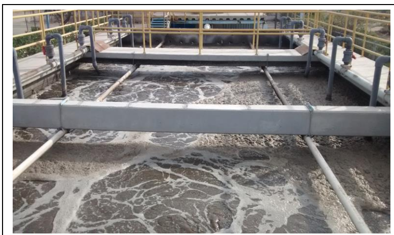
Figura 25. Reactor biológico aerobio de la PTAR CETYS
