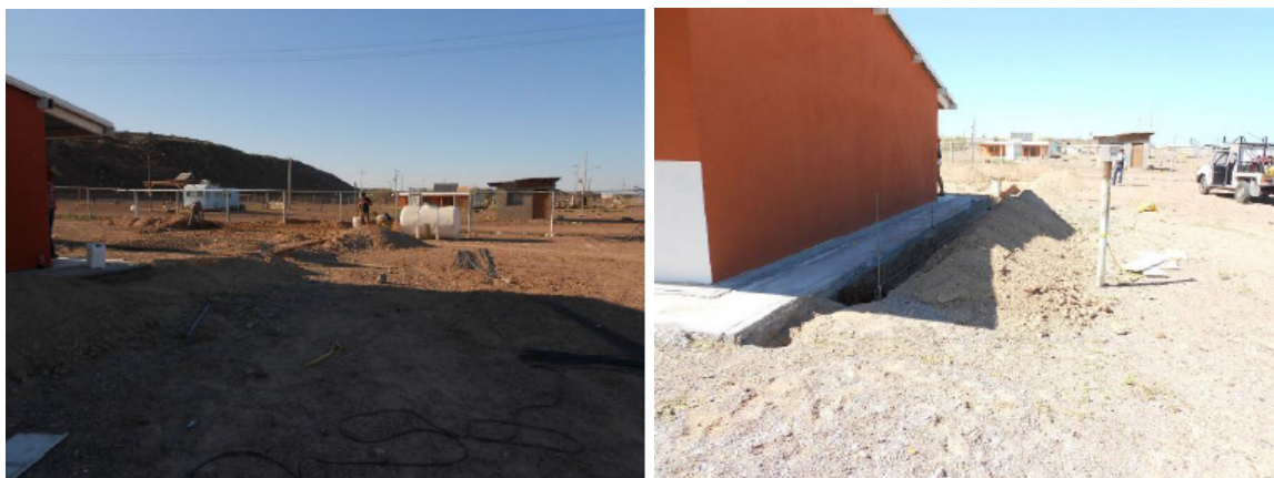
(a) Inicio de excavaciones
