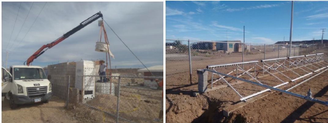
(c) Montaje de la torre de enfriamiento
