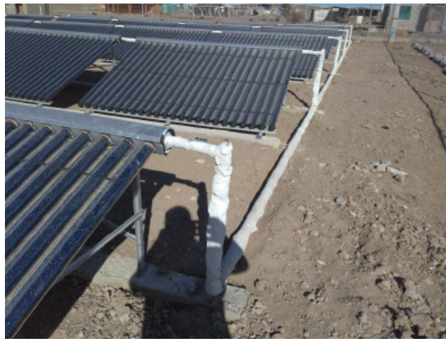
(b) Instalación hidráulica de colectores solares
