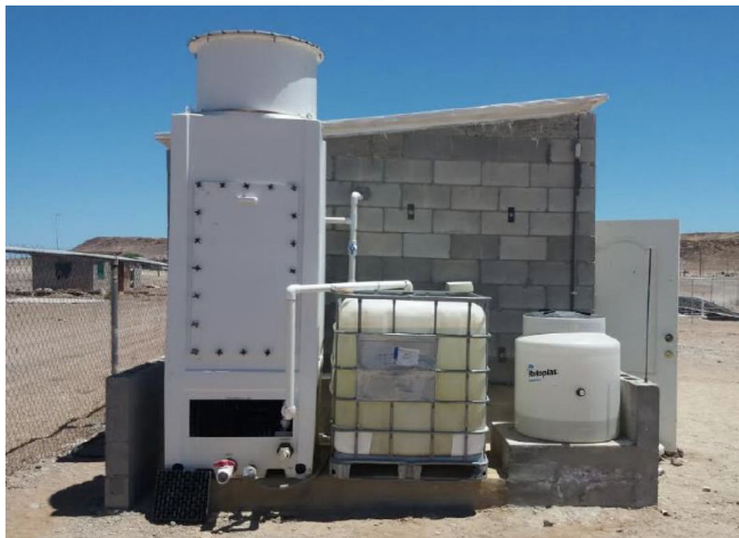
(a) Circuito de enfriamiento terminado
