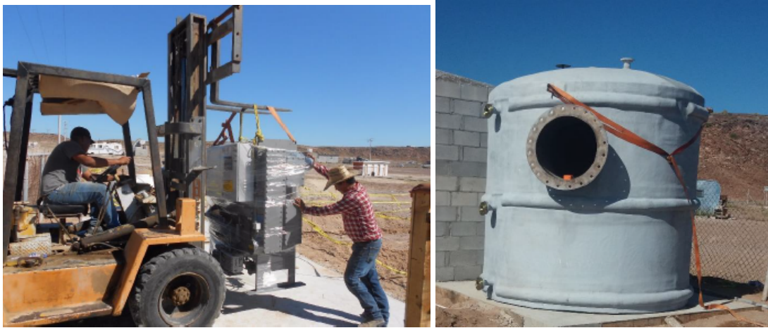
(a) Montaje del chiller LUCY
