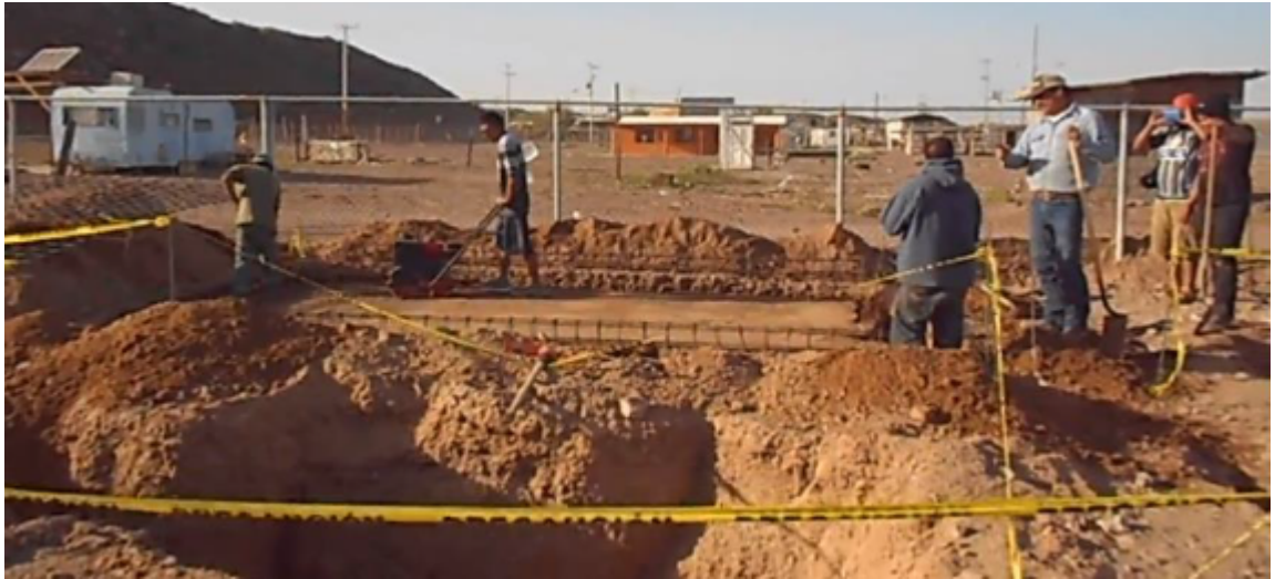
(a) Excavación y cimentación de la losa A.
