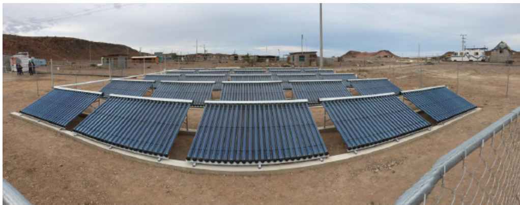
(d) Campo de colectores solares terminado
