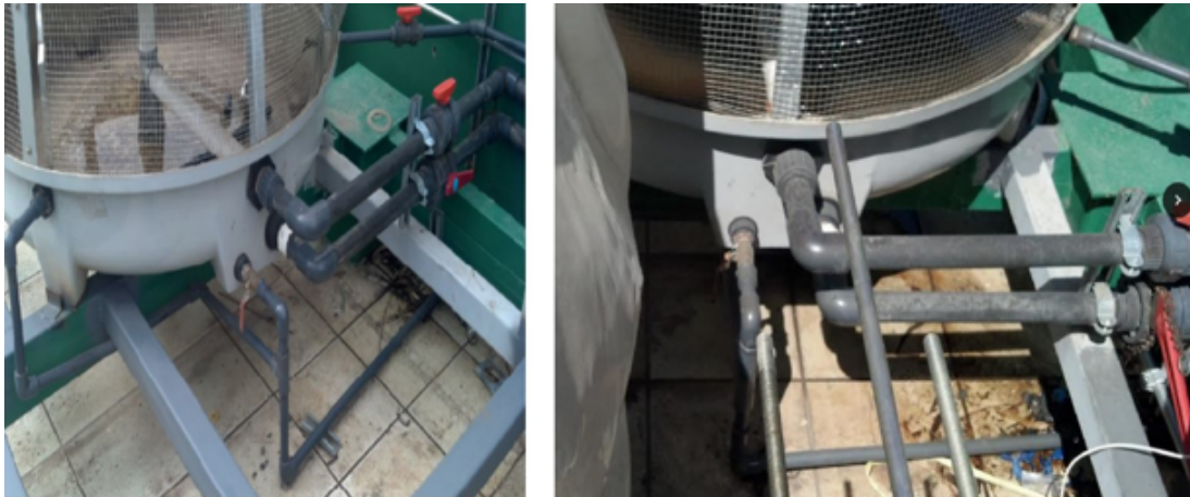
Figura 4.8: Circuito hidráulico de agua de enfriamiento.
