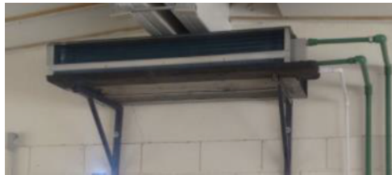
Figura 4.46: Manejadora de agua fría.
