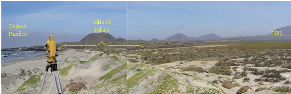
Figura 16. Imagen que muestra el sitio de trabajo en Las Lajas. (Foto del autor)
