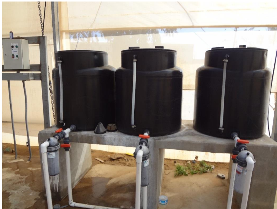
Figura 33. Contenedores para la Solución Nutritiva. FINSQ
