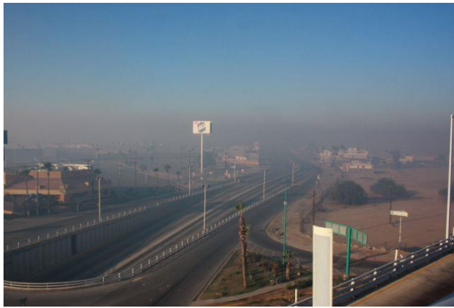
Figura 1.5. Contaminación del aire. Puente en Bulevar Adolfo López Mateos, Mexicali.
