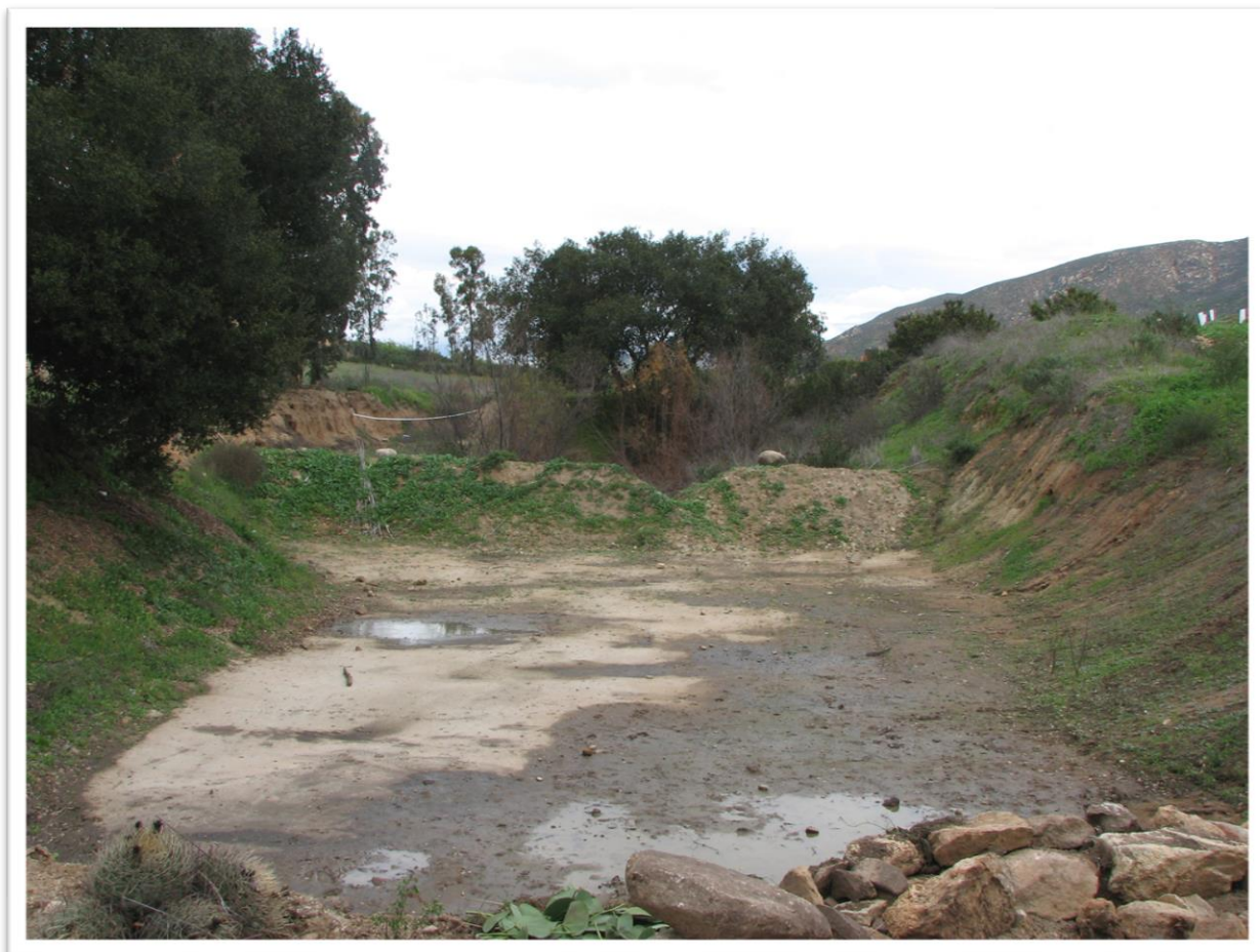
Fotografía 2. Sitio designado para el humedal artificial. Fotografía propia tomada al inicio de la temporada de lluvias (2019). Esta excavación corrientemente funge como una charca vernal.
