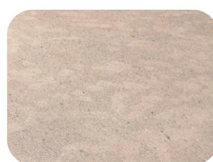
Piso compactado de arena gruesa
