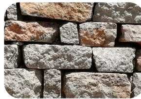
Enladrillado sin junta
