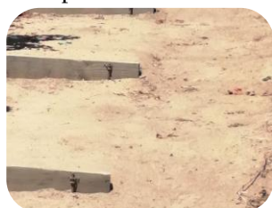
Escalonamientos con madera y tierra suelta
