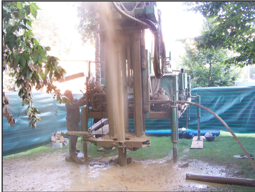
Fig. 26.- Perforación del sondeo de investigación en el Campus de Ourense (Septiembre 2007)
