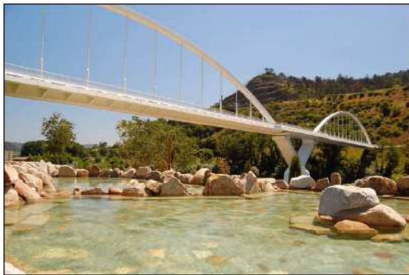
Figura 4. Pasarela peatonal que ha afectado a los manantiales de Outaríz.
