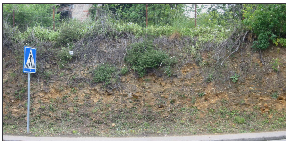
Fig. 22.- Tercer nivel de Terrazas correspondiente al Campus de Ourense
