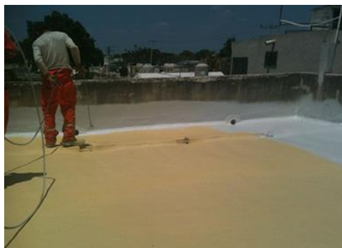
Figura 3.3 Aislamiento de un techo con poliuretano espreado.
