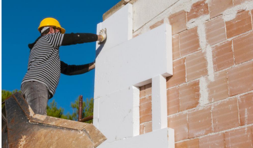
Figura 3.2 Aislamiento de un muro con poliestireno.
