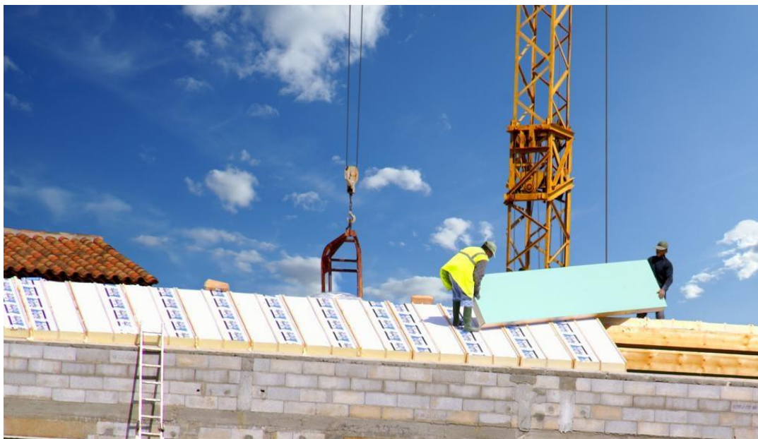
Figura 3.5 Aislamiento de un techo con poliestireno.
