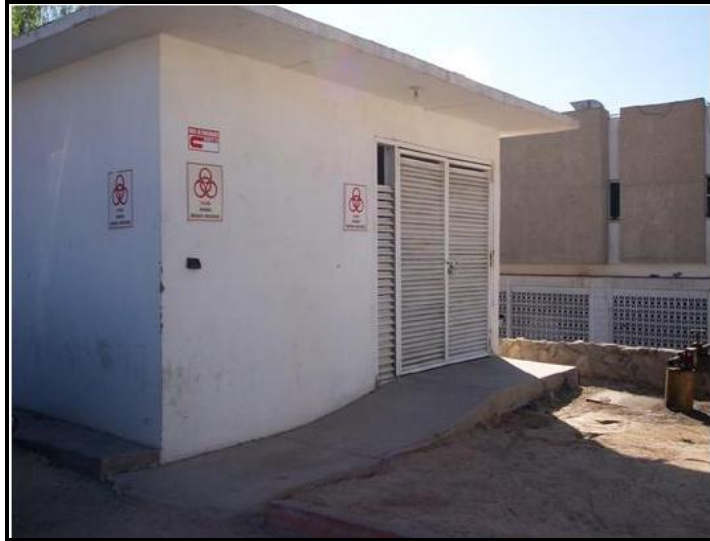
Foto 4. Almacén temporal de RPBI. Fuente: Armijo C. (2002). Diagnóstico de la generación, transporte, tratamiento y disposición final de los residuos hospitalarios en Mexicali. Reporte de investigación.
