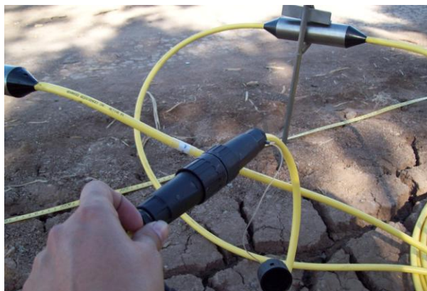
c) Electrodo hincado en el terreno y conector que lo comunica al cable conductor
