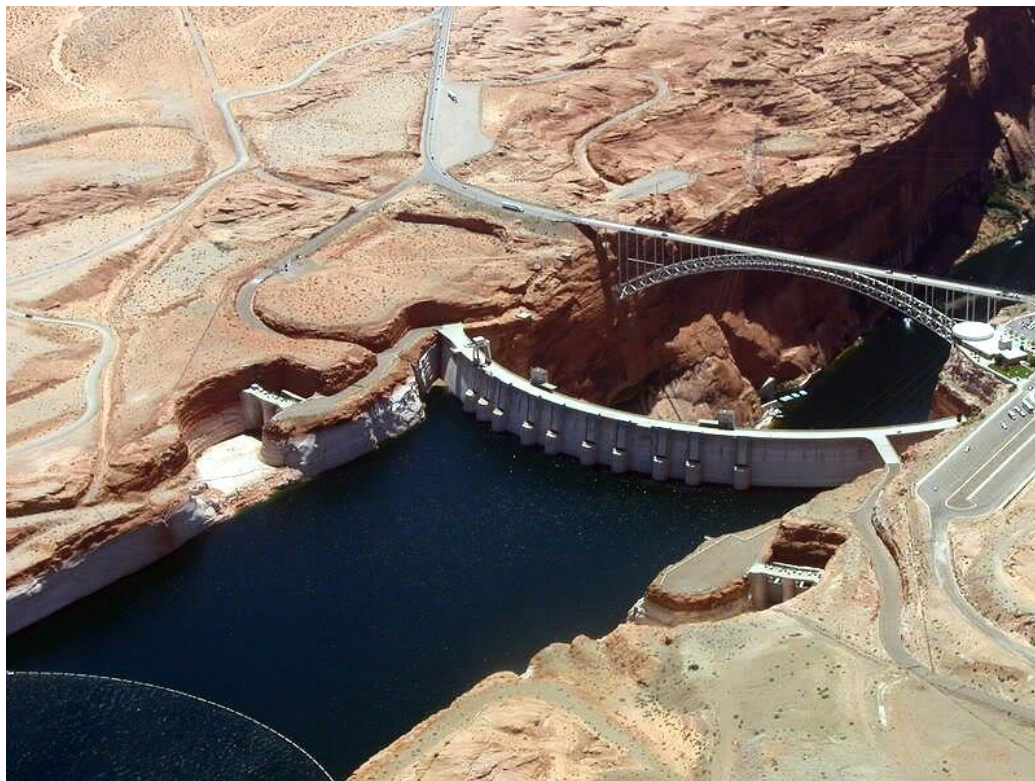
Figura No. 4.- Nos muestra la Presa Glenn Canyon, terminada el año de 1963, en el cauce del Río Colorado. Foto tomada del sitio de Internet http://guias-viajar.com/estados-unidos/arizona/page-hoteles-moteles-excursiones-lake-powell/ .
