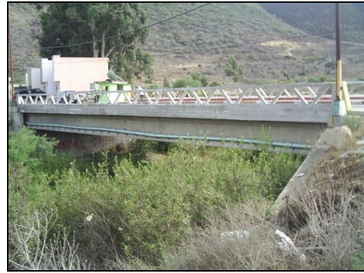
Figura 7 Vista desde aguas arriba del puente Villabonita
