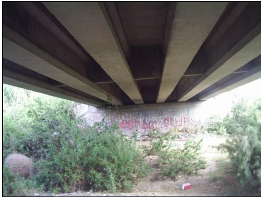
Figura 6 Vista desde abajo del puente Villabonita
