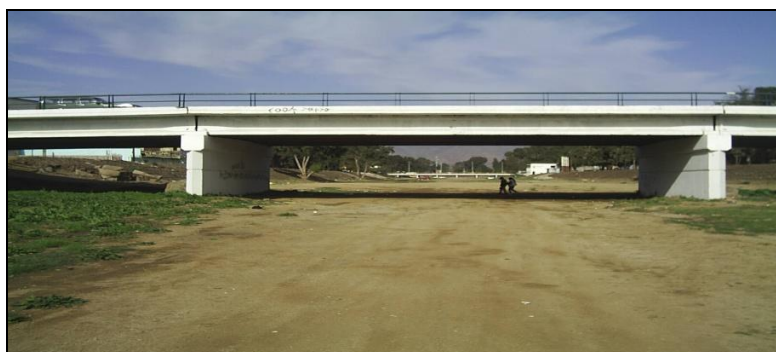
Figura 4 Fotografía del puente de la calle Segunda, desde aguas abajo (vista desde el mar).
