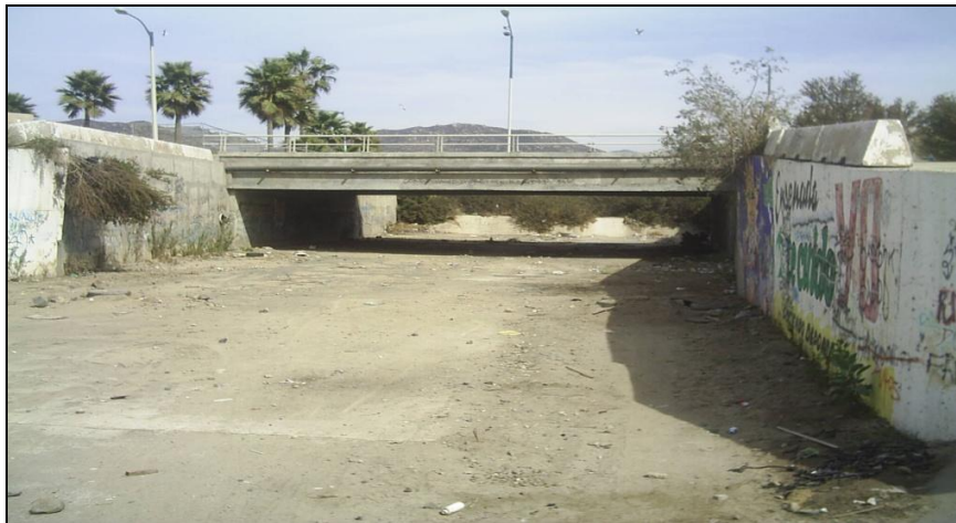
Figura 10 Fotografía del puente El Gallo desde el cauce aguas abajo.
