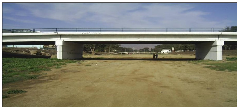
Figura 8 Fotografía del puente 2, calle Segunda, desde aguas abajo (vista desde el mar).
