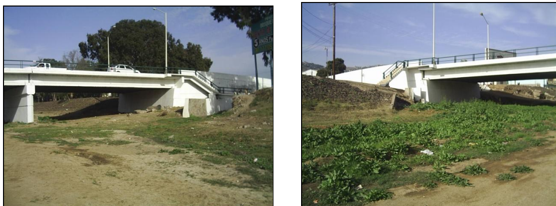
Figura 7 Fotografías de ambos estribos del puente 2, calle Segunda.
