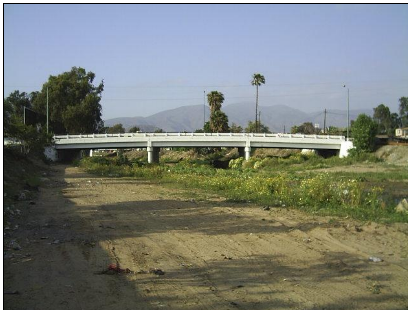
Figura 12 Fotografía del puente de la calle Nueve tomada desde aguas abajo.
