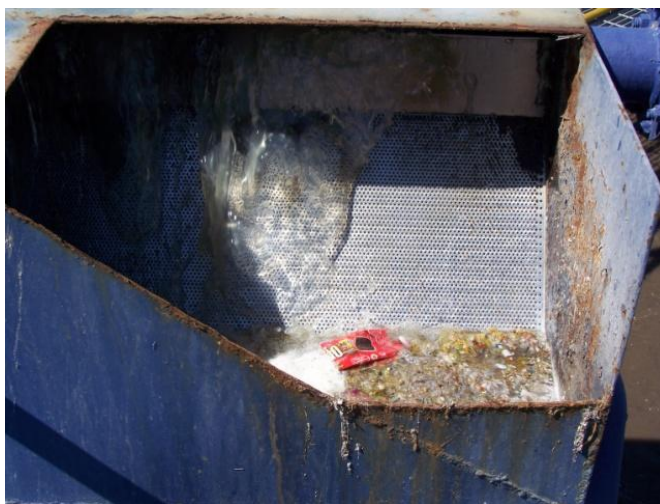
Figura 40. Mantenimiento y modificación de la criba de finos de la PTAR-UABC.
