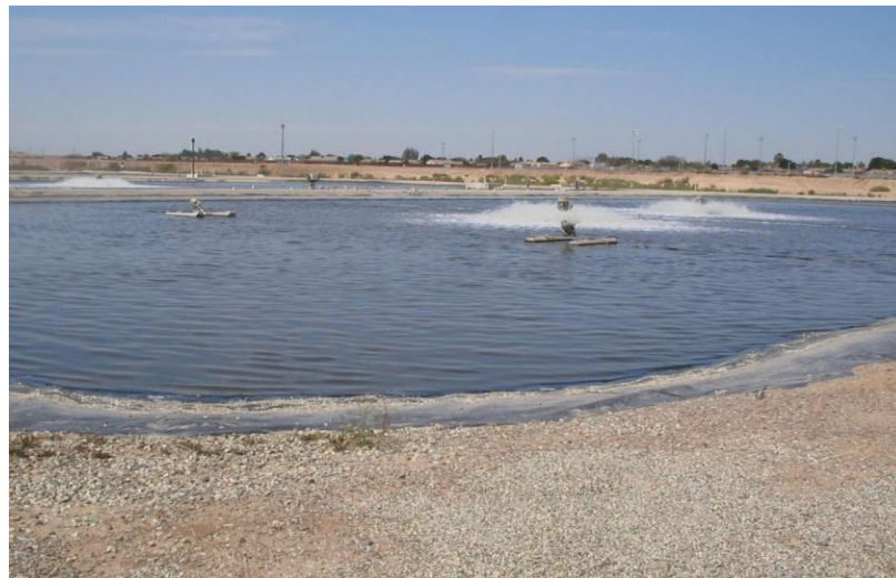
Figura 5. Laguna de la planta tratadora de aguas residuales de la ciudad de Calexico, Ca.
