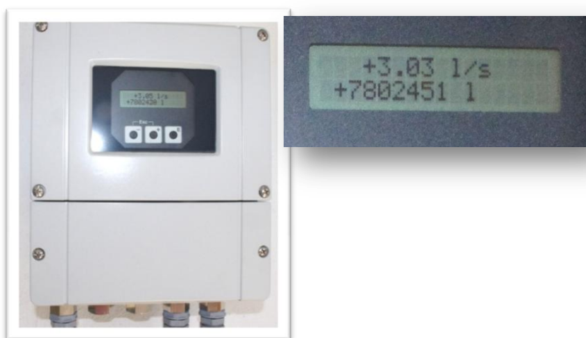
Figura 34. Medidor de flujo de la PTAR-UABC
