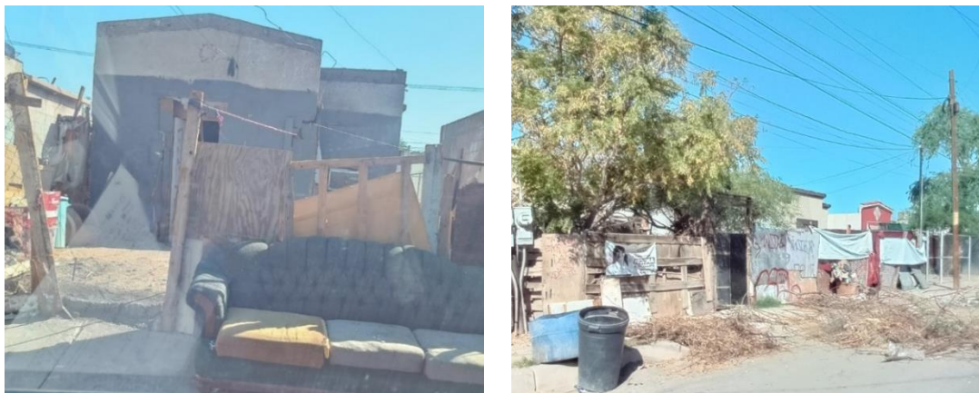
Figura 8. Viviendas abandonadas en Ángeles de Puebla.
