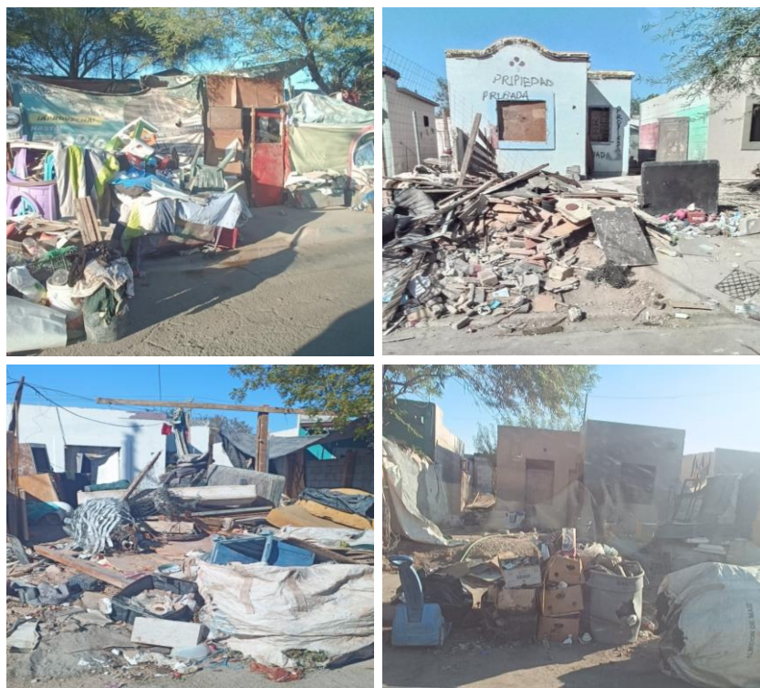
Figura 13. Viviendas habitadas con deterioro Fraccionamiento Ángeles de Puebla.
