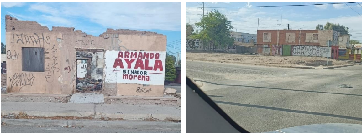
Figura 6. Viviendas deshabitadas en Pueblo Nuevo.
