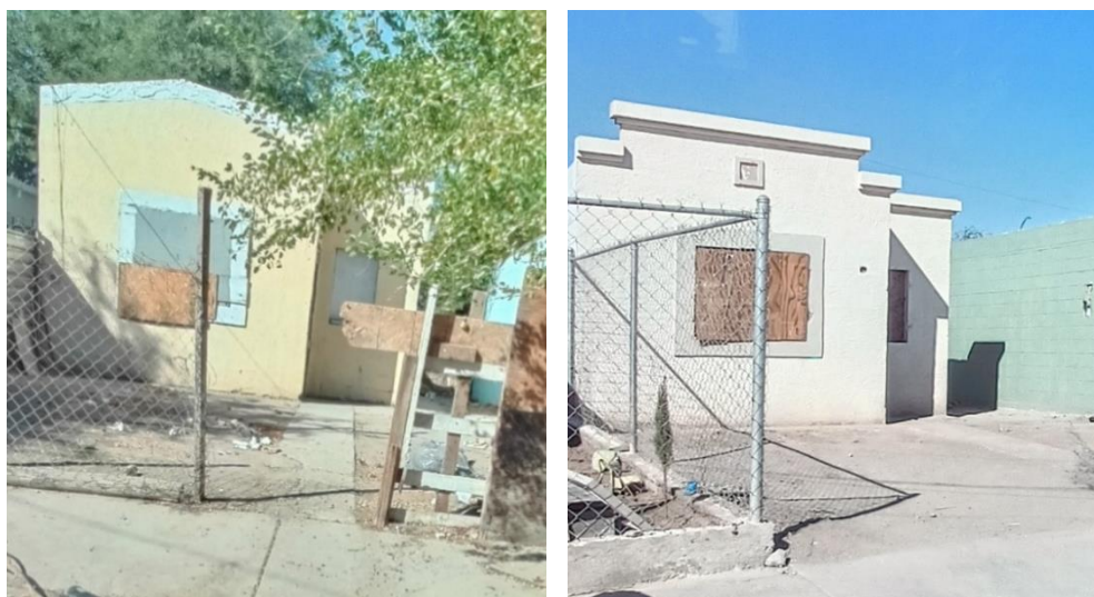
Figura 14. Viviendas deshabitadas sin deterioro Fraccionamiento Ángeles de Puebla.
