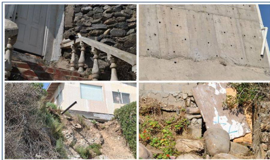
Fotografía 6. Descargas de aguas negras por la zona habitacional cercana a la playa.
