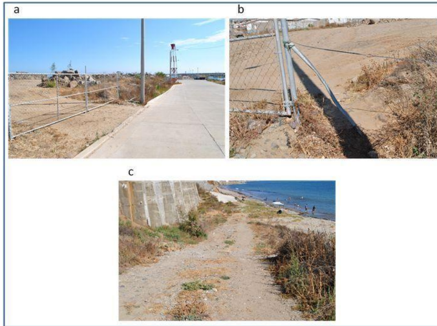
Fotografía 1. Acceso uno. a) Rumbo al puerto de El Sauzal, b) infraestructura del acceso y c) rampa para acceder a la playa Stacks.
