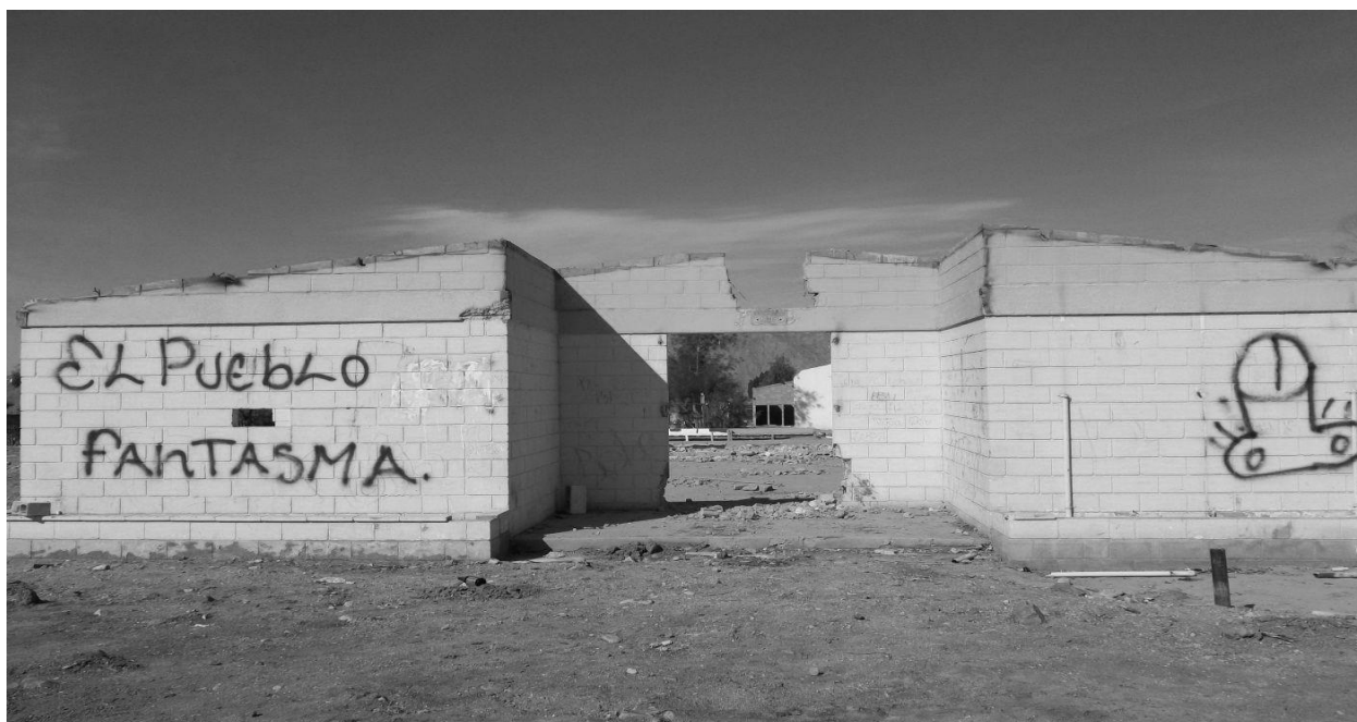
16. Vista del ex salón social antes de ser derrumbado en el Ej. Zacamoto. 15/03/ 2011
