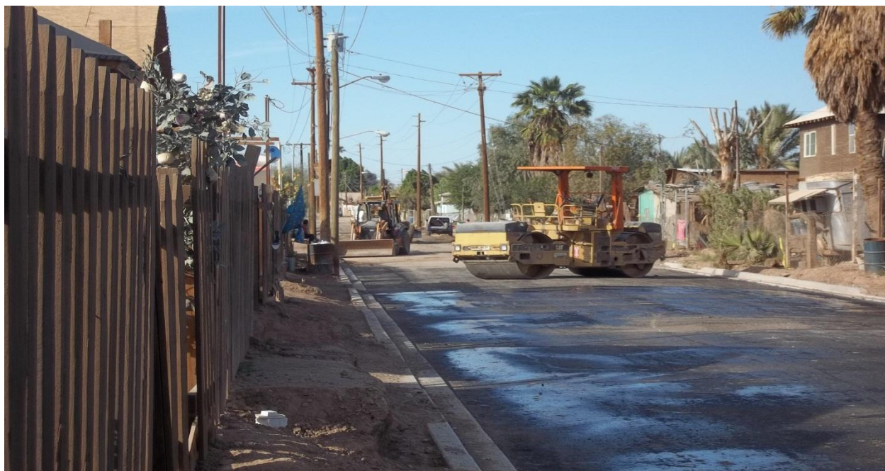
6. Proceso de pavimentación en las calles del Fraccionamiento Nuevo Hogar. 05/01/2012
