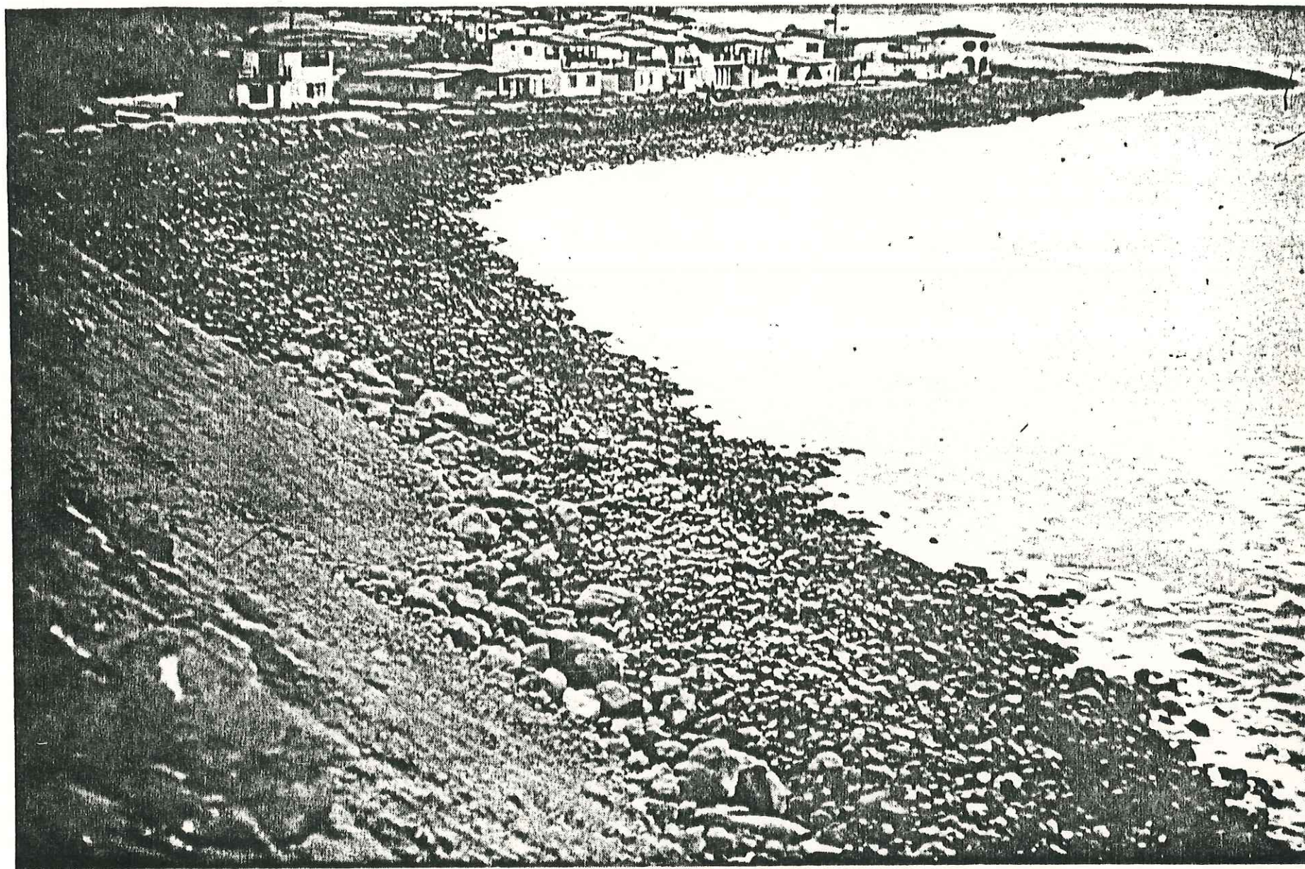
FIG. II.- ZONA DE DESEQUILIBRIO AL ESTE DEL DESLIZAMIENTO. NOTESE LA AUSENCIA DE ARENA Y DE MATERIAL MAS FINO, TAMBIEN OBSERVENSE LAS DOS BERMAS. ( FOTO DE M.K. GAUGHAN )
