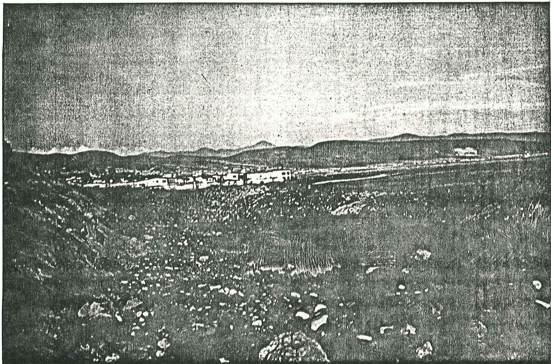
FIG. 8.- LA LAGUNA QUE SE FORMO COMO CONSECUENCIA DEL DESLIZAMIENTO EL 23 DE AGOSTO DE 1976. NOTESE A LA DERECHA EL PROMONTORIO DE ROCAS Y ARENA, MISMAS QUE ESTAN A 5 METROS SOBRE EL NIVEL MEDIO DEL MAR. ( FOTO DE M.K. GAUGHAN )
