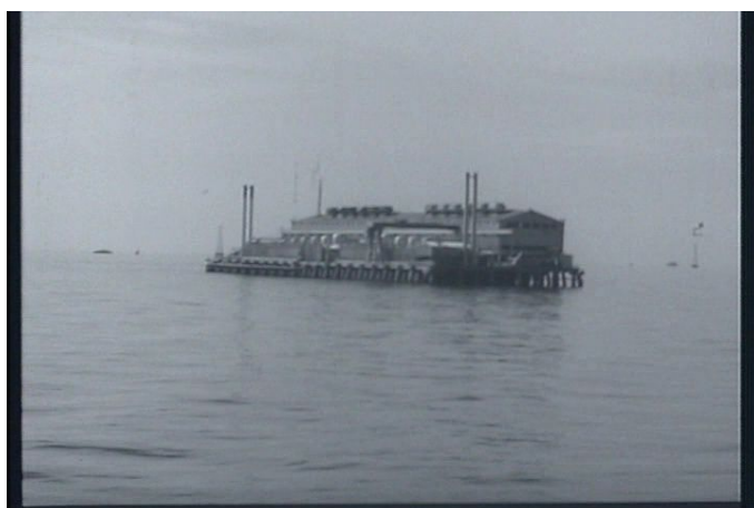
Ciencia y tecnologías al servicio de la producción: planta compresora de gas que será reinyectado a los pozos para sacar más petróleo (escena 4.23.73)
