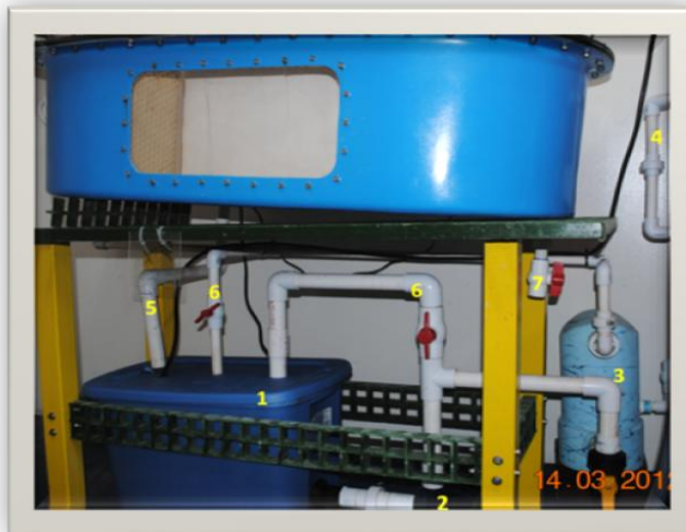
Figura 2.- Diseño del sistema de recirculación conectado a las cámaras respirométricas.
