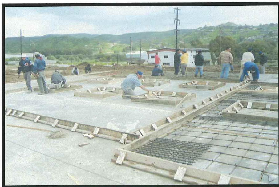
Fig. 5.3 Fotografía que muestra el armado en la esquina de un muro con abertura para ventanas.
