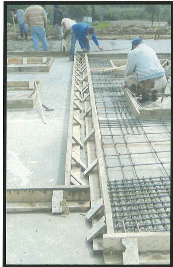
Fig. 4.7 Cimbrado de muros contiguos. No se debe de olvidar la correcta forma de cimbrar los muros para evitar el pandeo de los mismos.
