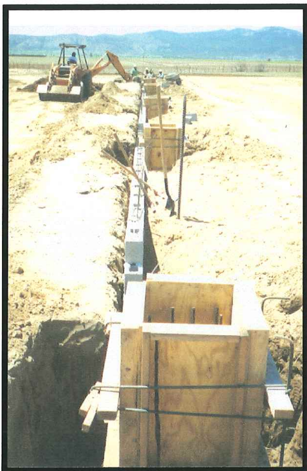
Fig. 3.13 Es muy importante que la cimbra de la cimentación este nivelada y alineada correctamente.
