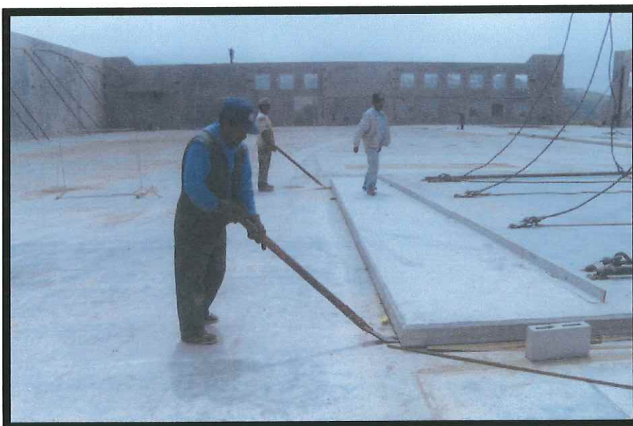
Fig. 4.5 El espacio entre la cimbra de los muros nos permitirá usar una cuña para levantar los muros en caso de que el líquido desencofrante no funcione.
