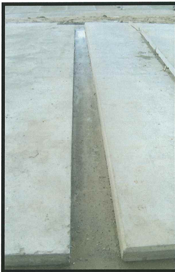
Fig. 4.4 Otra consideración que hay que tomar en cuenta cuando se planea la distribución para el cimbrado de muros es cuanto espacio se debe dejar entre ellos.
