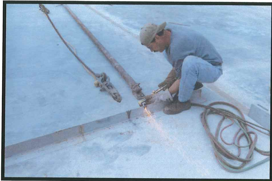
Fig. 4.29 En esta imagen se aprecia el ángulo en dónde serán apoyados los polines para soportar la lámina de azotea.
