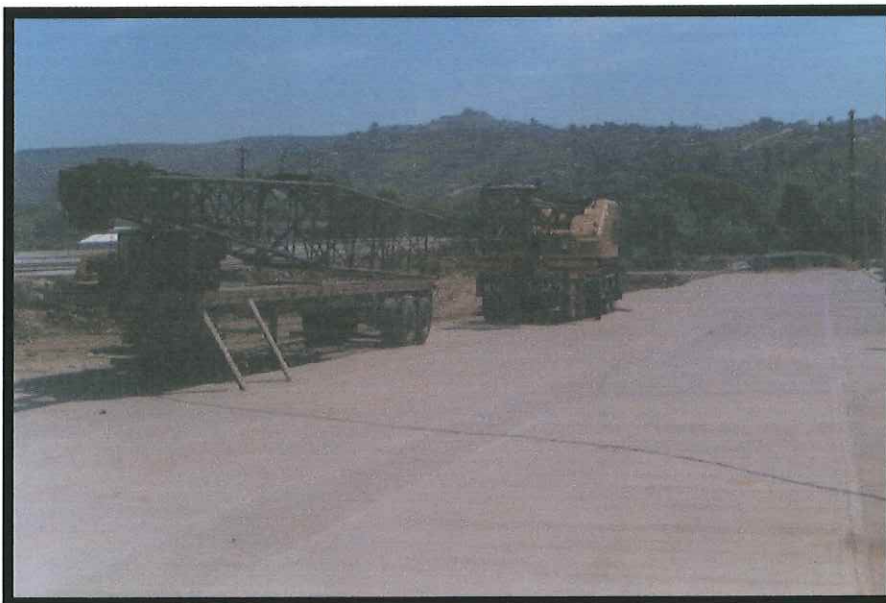
Fig.2.2 Grúa de 60 toneladas para el izamiento de los muros .
