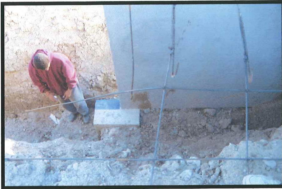
Fig. 3.8 Las zapatas aisladas se construyen debajo de la unión de dos muros, para que así cada cimentación soporte la mitad del peso de cada muro.
