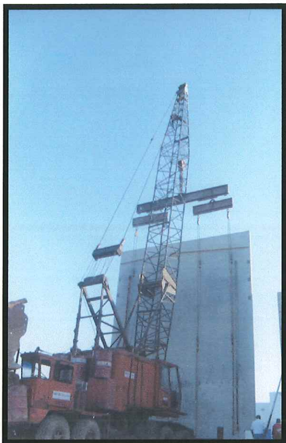
Fig.2.6 Apuntalamiento de Muros Tilt-Up
