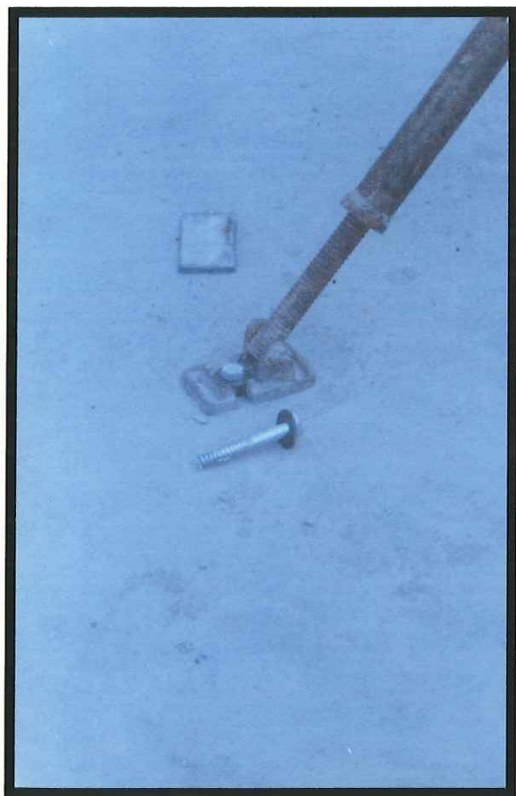
Fig. 4.15 Anclaje de apuntalamiento en losa de piso
