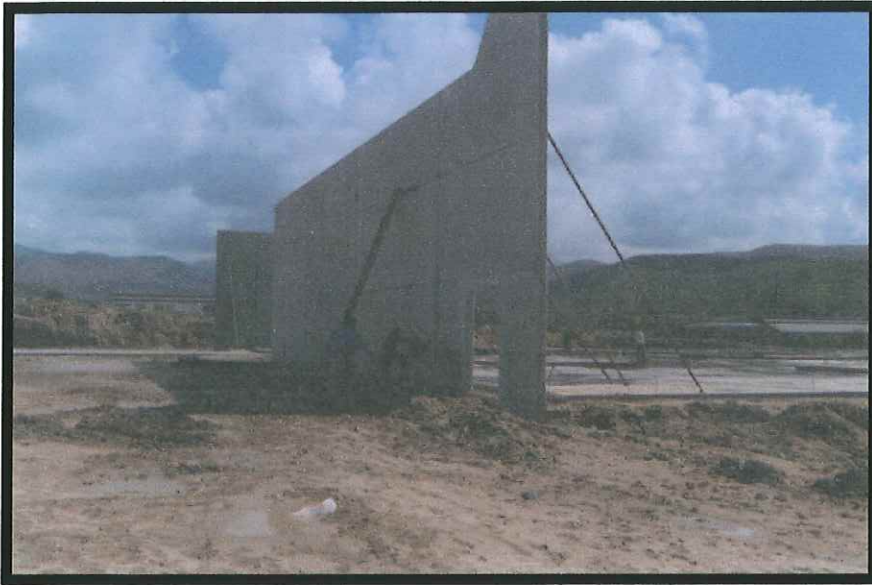
Fig. 1.1 Construcción de Edificio Tilt-UP de 5,000 metros cuadrados, para electrónica "Levitz", en parque industrial ubicado en El Sauzal de Rodríguez, Ensenada B.C. México.
