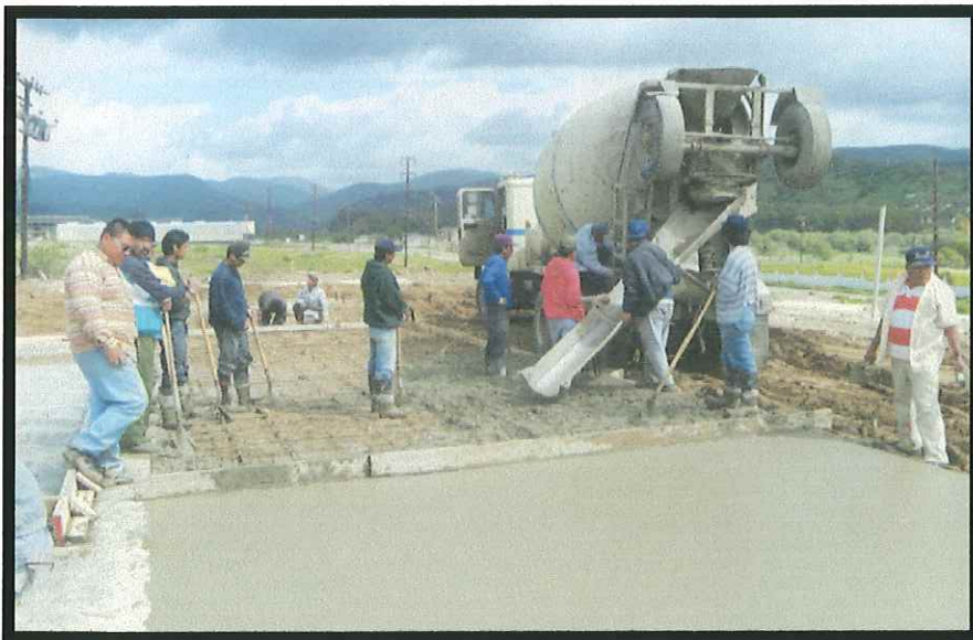
Fig. 3.1 Construcción de una losa de piso armada con varilla de 3/8" a cada 45 cm en ambos sentidos.
