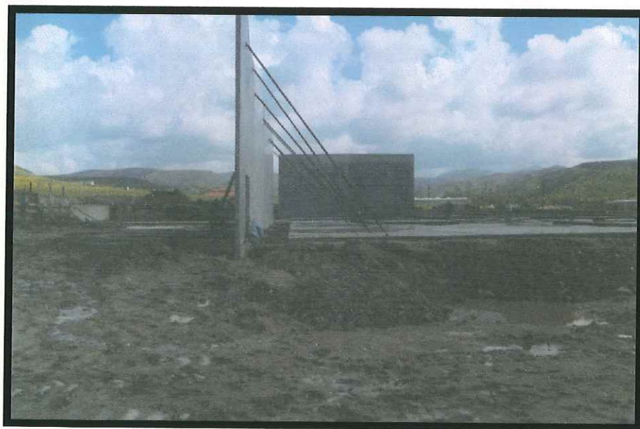
Fig. 4.21 La cuadrilla de trabajadores, con la ayuda de algunas barras, y en coordinación con el operador de la grúa, colocan los muros alineados y a plomo.
