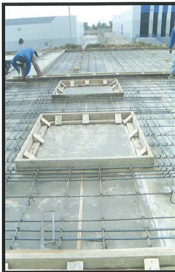
Fig. 4.12 En ésta fotografía se muestran dos muro listos para colar. El acero de refuerzo se encuentra a la mitad del muro soportado por silletas y al fondo se pueden observar ocho insertos de izaje.
