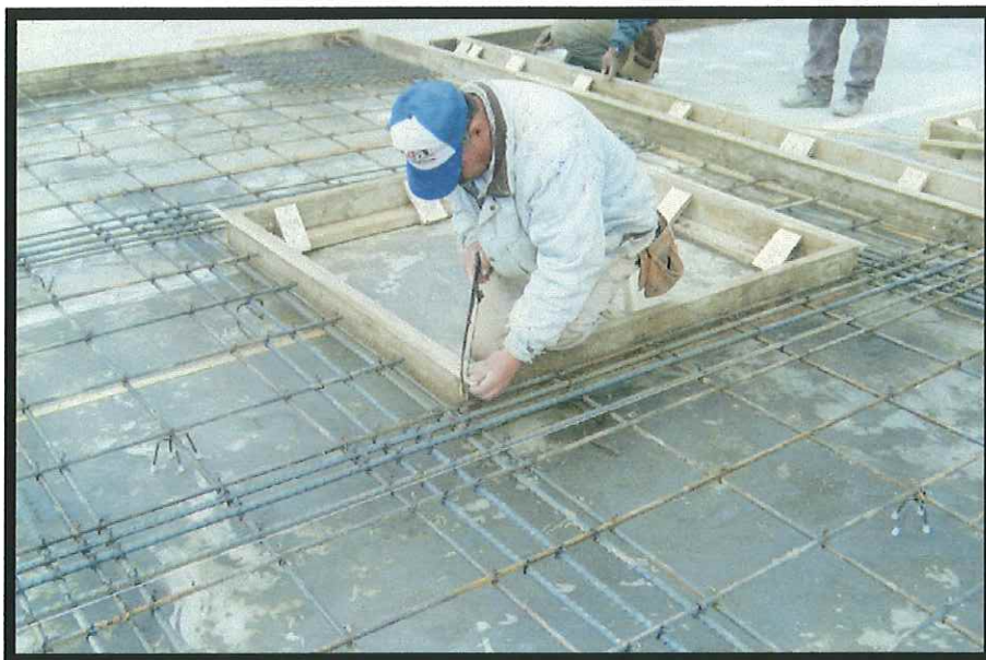
Fig. 4.11 El acero de refuerzo se coloca al centro del muro y la parilla es soportada por silletas de acero.
