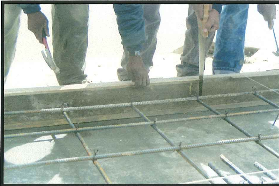
Fig. 4.8 Instalación de tiras de madera para crear una apariencia arquitectónica en el muro.
