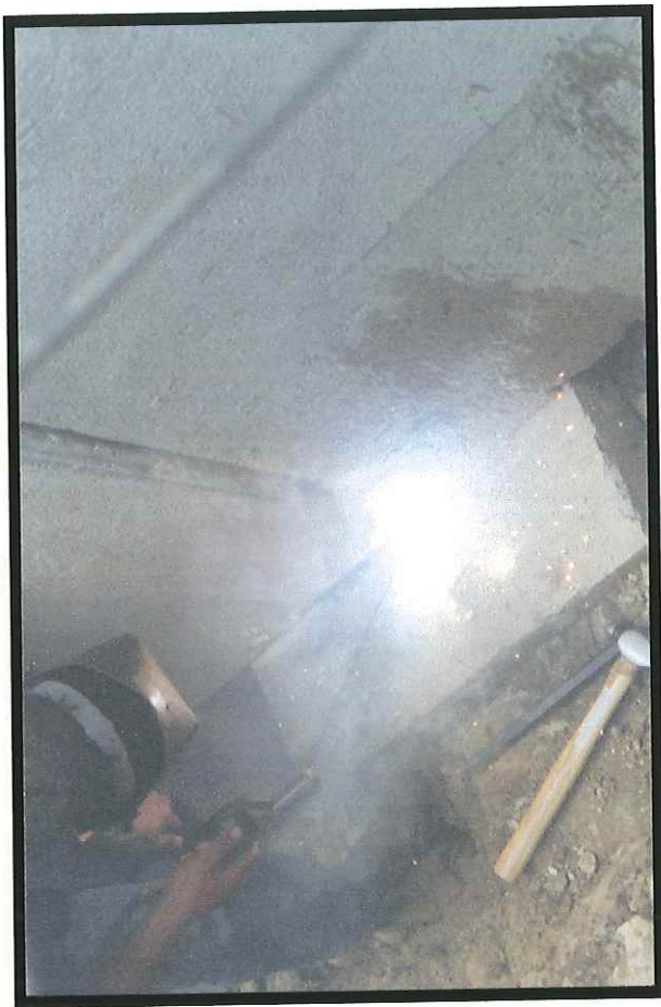
Fig. 4.31 Unión de muros con zapata aislada por medio de soldadura.
