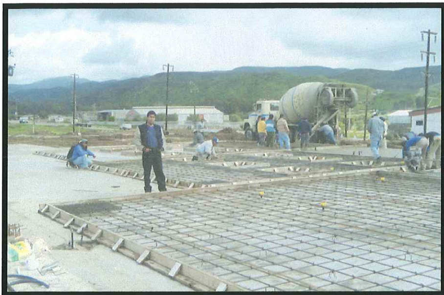
Fig.2.3 Cimbrado y Armado de un muro de Tilt-Up.
