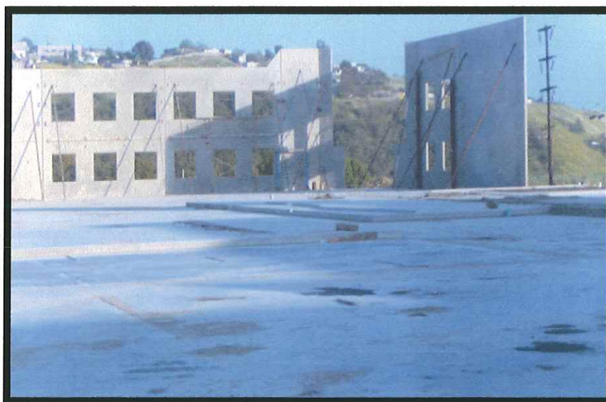
Fig. 4.17 En ésta fotografía se muestra el uso de contrafuertes en el izamiento de un muro.
