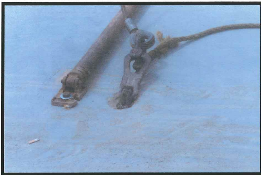
Fig. 4.14 En ésta imagen, de izquierda a derecha, podemos apreciar un muro con un anclaje para puntal y un anclaje para izamiento.
