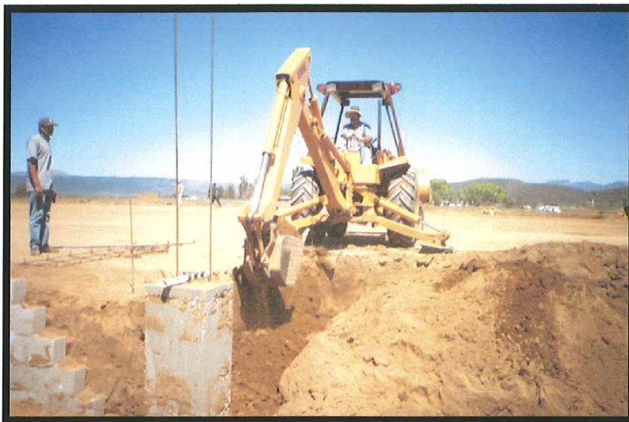
Fig. 3.6 Excavación de zanja para alojar la cimentación de zapata corrida.
