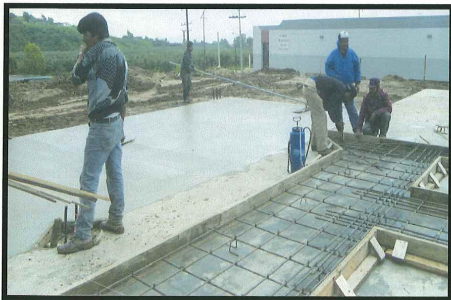
Fig. 3.5 El acabado de los pisos es muy importante ya que se usaran como cimbra de los muros.
