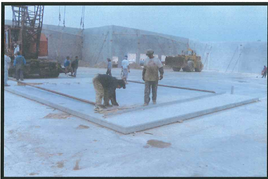
Fig. 4.23 Una vez que los cables han sido separados de los insertos de izaje, la grúa empieza a maniobrar hacia el lugar en donde habrá de izar un muro más.
