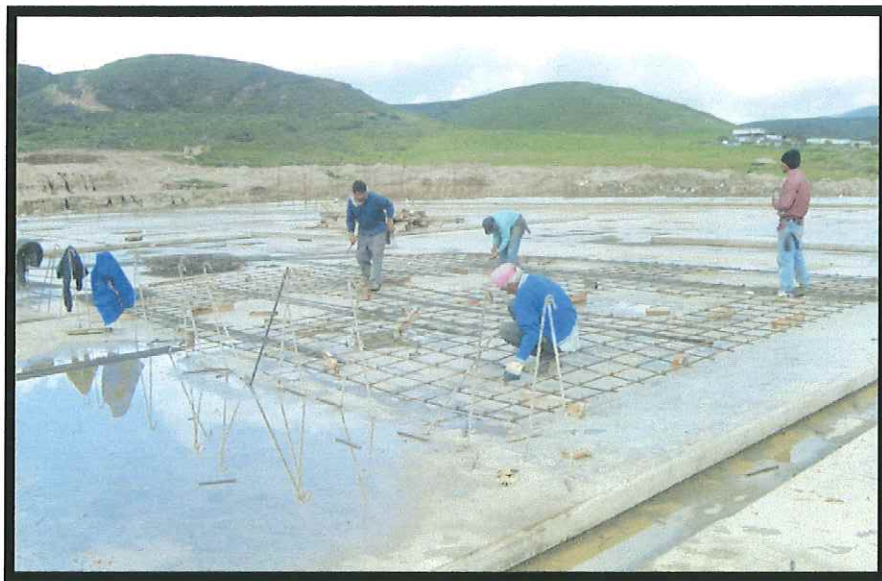
Fig. 4.10 Armado de parrilla de acero de refuerzo con varilla de 1/2" en ambos sentidos.
