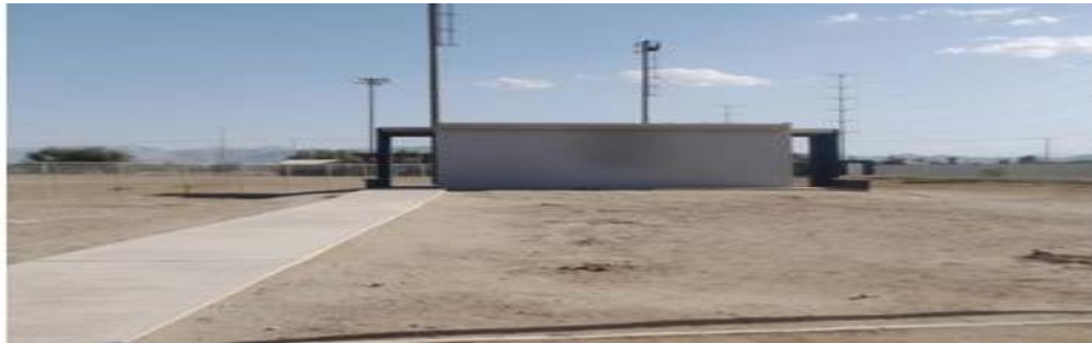
Figura 41. Conjunto de baños públicos del PAHB.
