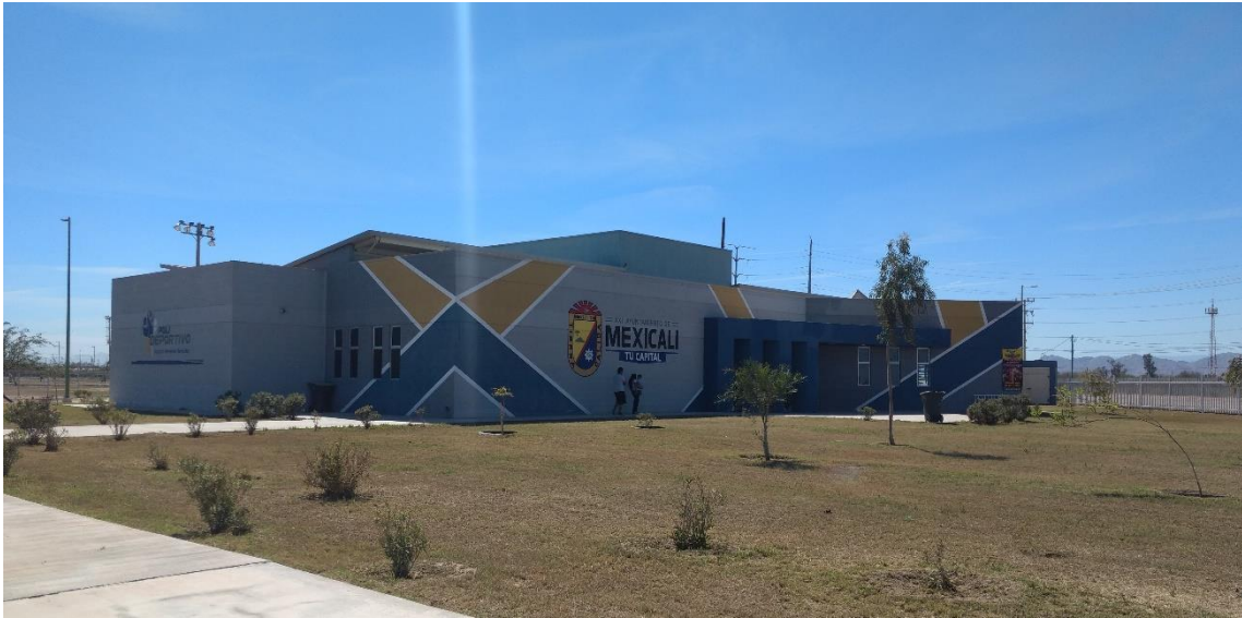
Figura 6. Salón de usos múltiples del PAHB. Fuente: Propia. Tomada en el sitio.
