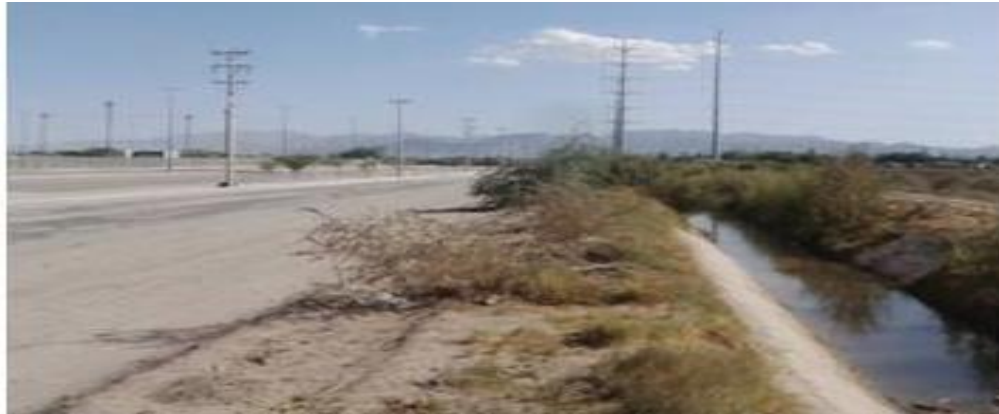
Figura 38. Calle y dren de lado oeste del PAHB.
