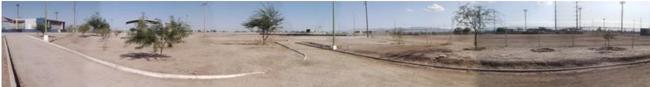
Figura 19. Vista panorámica de circuito lado sur del PAHB.
