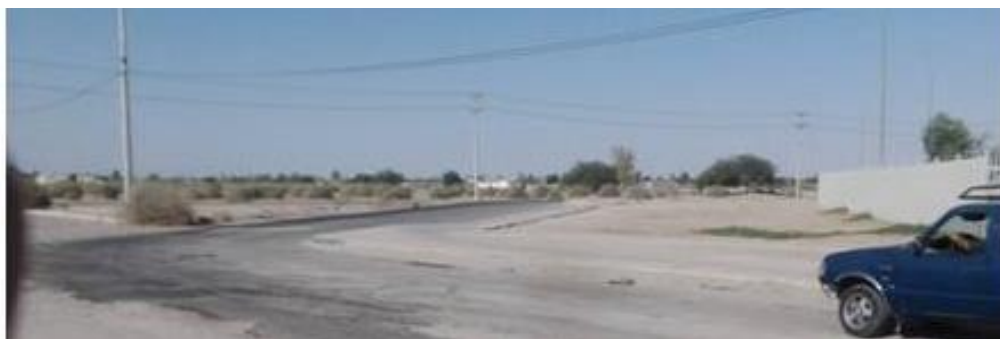
Figura 40. Calle Norte del PAHB.
