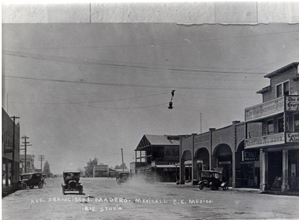
Figura 10. Después del incendio de 2 de diciembre de 1920, se reconstruyó el teatro y después de varios meses la construcción fue modificada en su fachada frontal a como la podemos observar en esta imagen. Renombrado como “Cine México”, a los costados se aprecian la tienda de ropa Las Tres BBB y la Cantina Alemana, Circa, 1921-1922.
