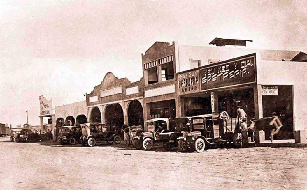
Figura 26. Av Reforma, se puede observar las edificaciones de “La Chinesca”, aunque no se explica si fue tomada antes o después del incendio de 1923. De izquierda a derecha, la primera edificación blanca con tres arcos, es el local que acogió al Teatro-cine “Iris”. Fototeca, Biblioteca del Estado de Baja California
