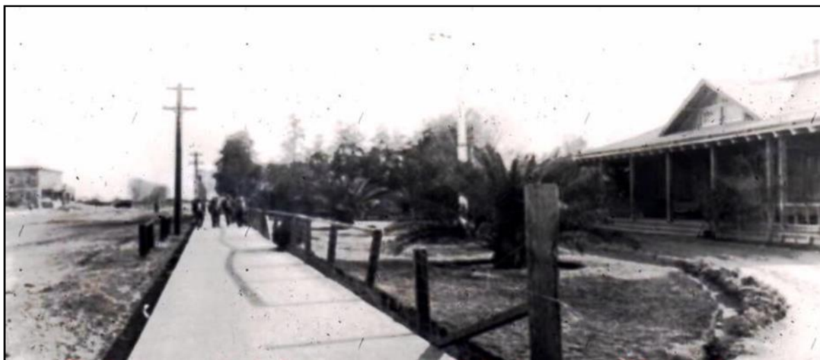
Figura 43. Oficinas del Ferrocarril Inter-California en Mexicali, 1916. Se puede observar al fondo la Escuela Cuauhtémoc.
