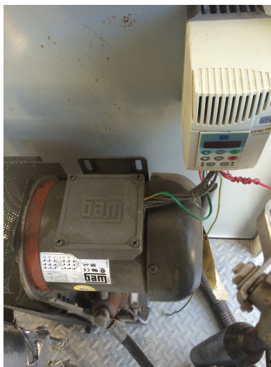
Figura 5.12: Instalación de bomba hidráulica y variador de frecuencia.
