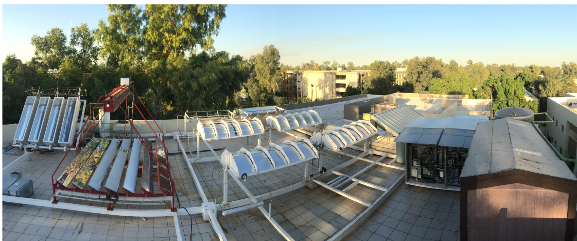
Figura 5.20: Instalación del sistema de aire acondicionado
