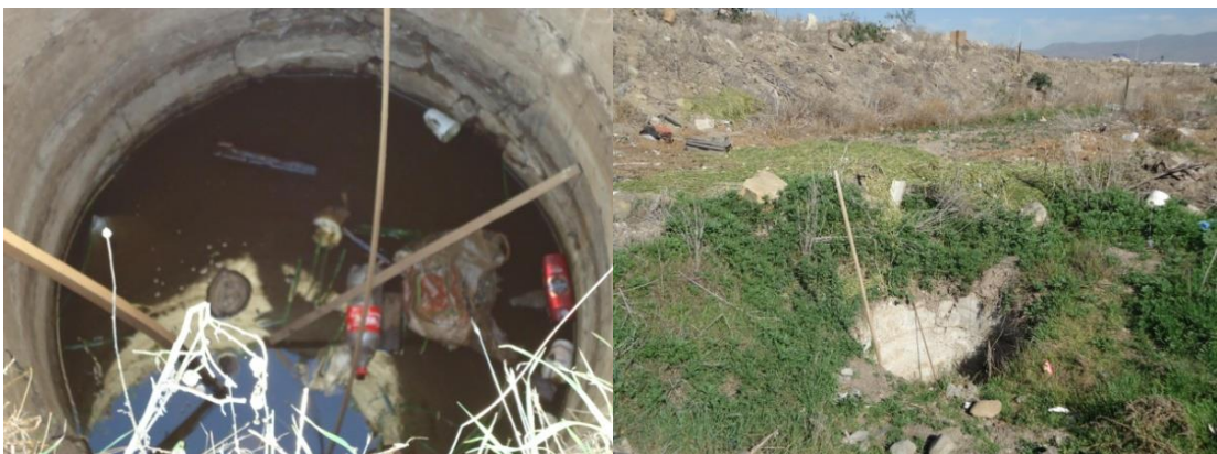
Figura 3.10 Pozo 6b, el cual se encuentra actualmente clausurado por la CONAGUA. (Fuente propia)
