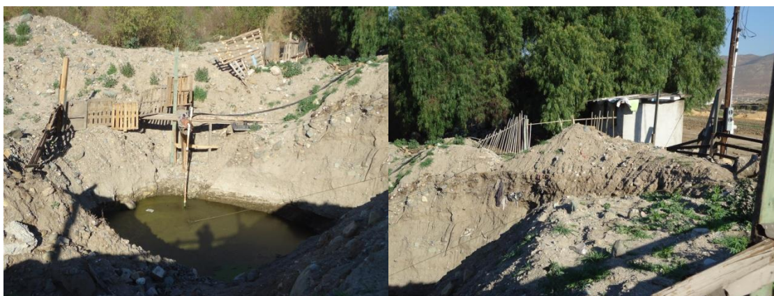
Figura 3.4 Pozo 1, ubicado en la tercer zona de estudio, donde se observa una letrina ubicada a un par de metros de la noria. (Fuente propia)
