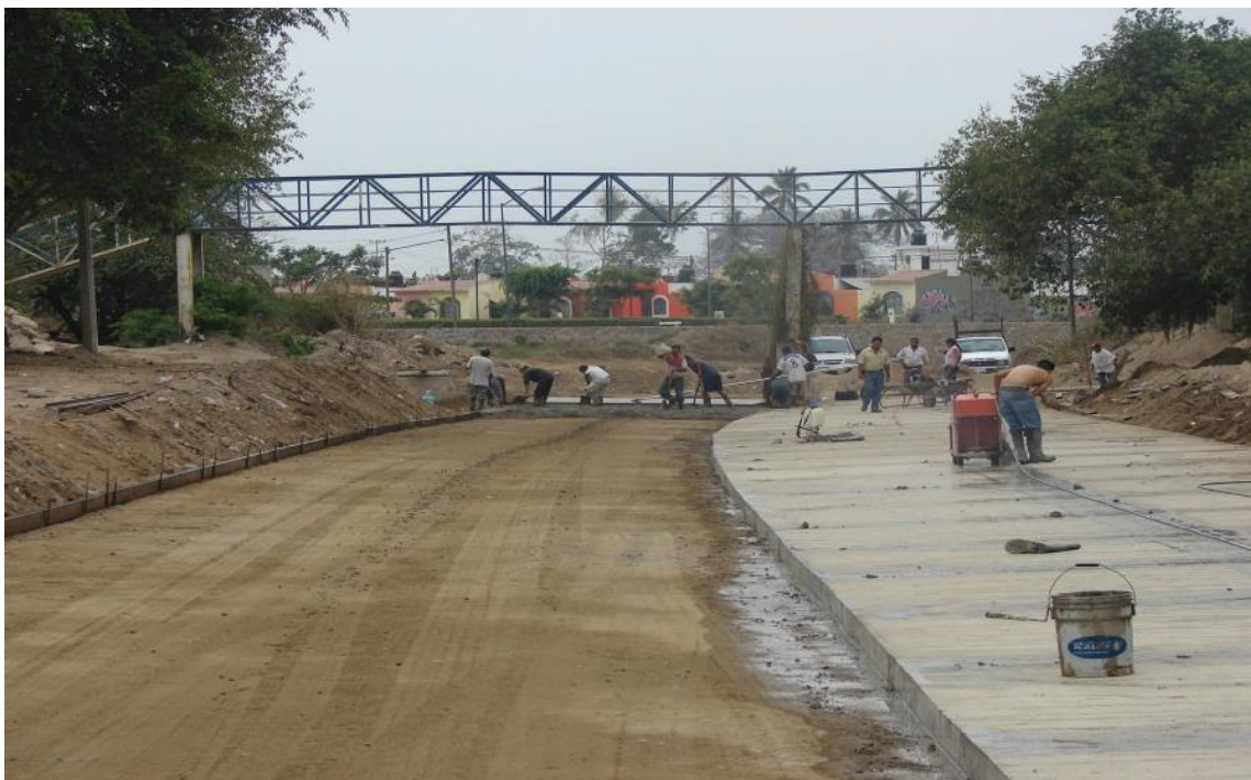
Figura 2.9 Avance de las obras de canalización del Arroyo Santiago (Ayuntamiento de Manzanillo, 2009)
