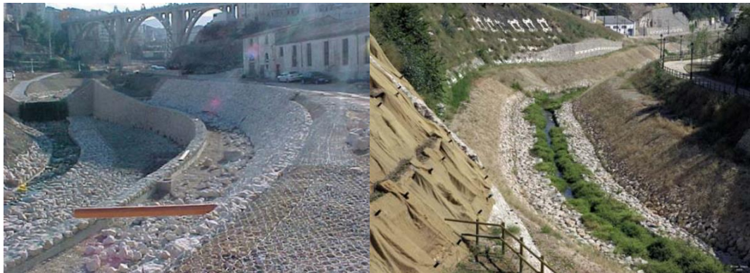
Figura 2.11 Encauzamiento conservando el hábitat natural en el Río Barxell. (Alarcón, 2009).
