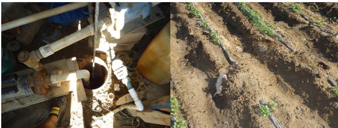
Figura 3.6 Pozo 3, protegido de la intemperie. (Fuente propia)
