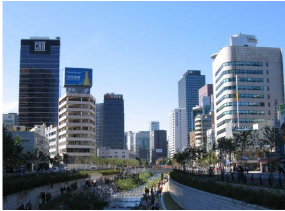
Figura 2. 5. Antes autopista, ahora parque. Fuente: Vergara, 2007.
