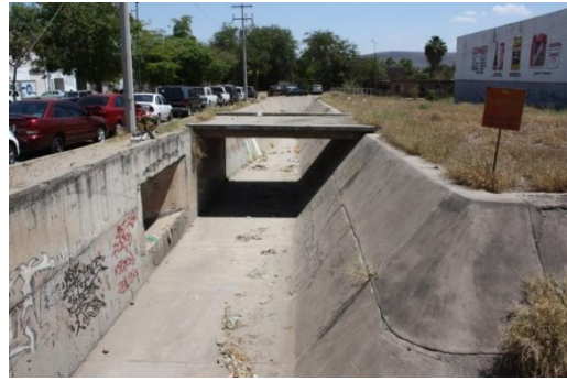
Foto 4. 5. Arroyo sin revestimiento y con revestimiento de concreto
