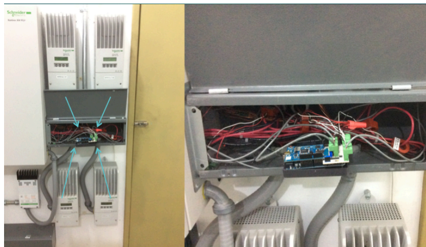
Figura 49, Instalación de los dispositivos de monitoreo de voltaje y corriente directa
