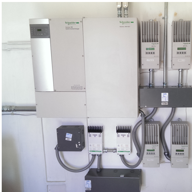
Figura 70, Instalación en el cuarto de control de controladores de carga solares, eólico e inversor/gestor de energía.
