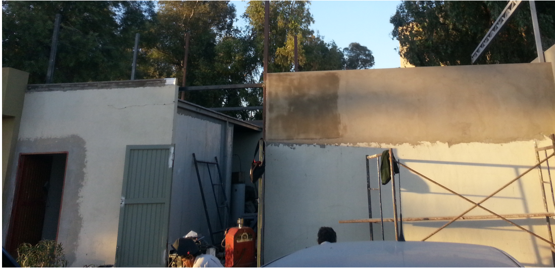
Figura 62, Construcción de cuarto de control.
