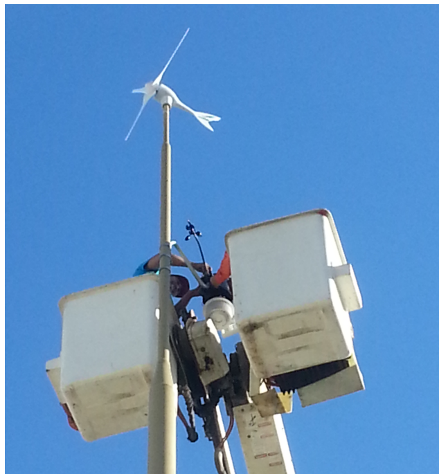
Figura 69, Instalación de Aerogenerador y Estación meteorológica a 16 metros de altura.
