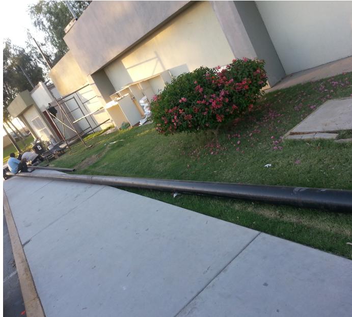
Figura 66, Construcción de estructura de aerogenerador
