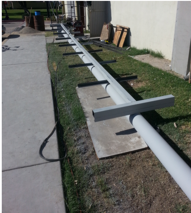
Figura 65, Construcción de Estructura de sistema de seguimiento en 1 eje.
