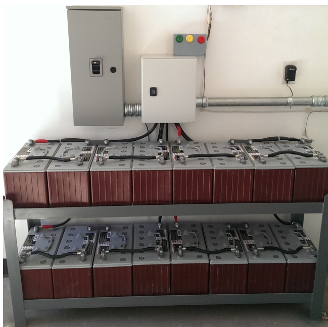
Figura 71, Instalación de baterías y desconectador en el cuarto de control
