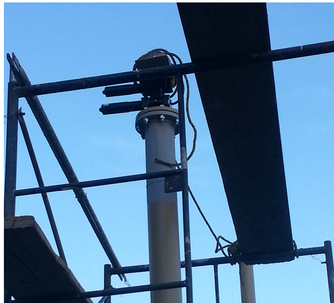
Figura 67, Instalación de motores para sistema de seguimiento
