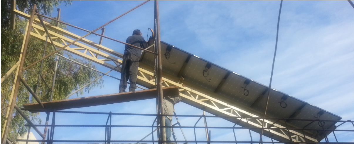
Figura 68, Instalación de paneles en sistema de seguimiento en 1 eje.
