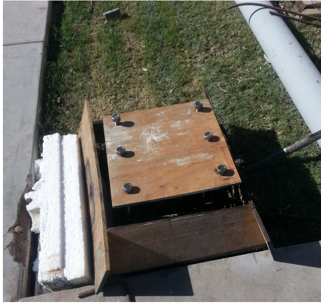
Figura 64, Base para sistema de seguimiento en 2 ejes.
