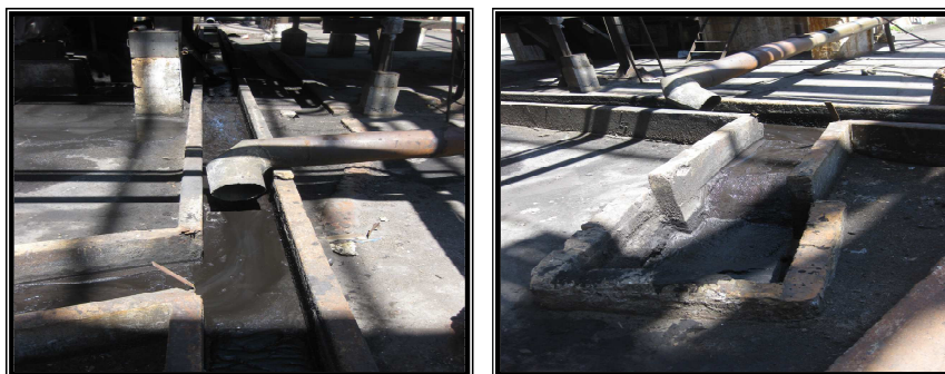
Figura 6. Aspecto de la zona donde se han canalizado los residuos.
