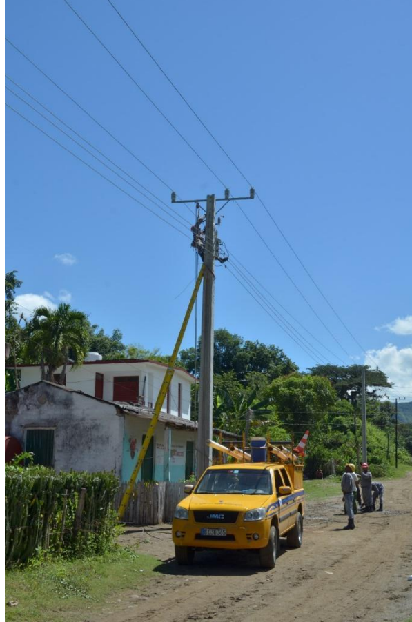
Figura No.22 Instalación del fluido eléctrico. Fuente: Especialistas de la OCC.
