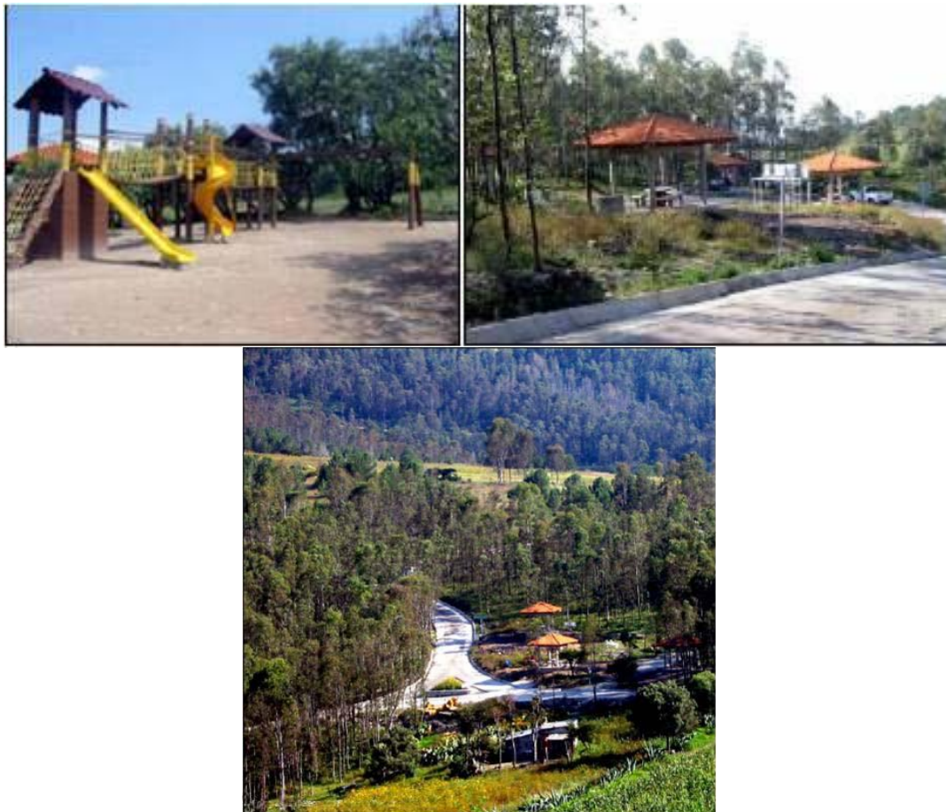
Figura 6. Obras para la recreación en el parque.
