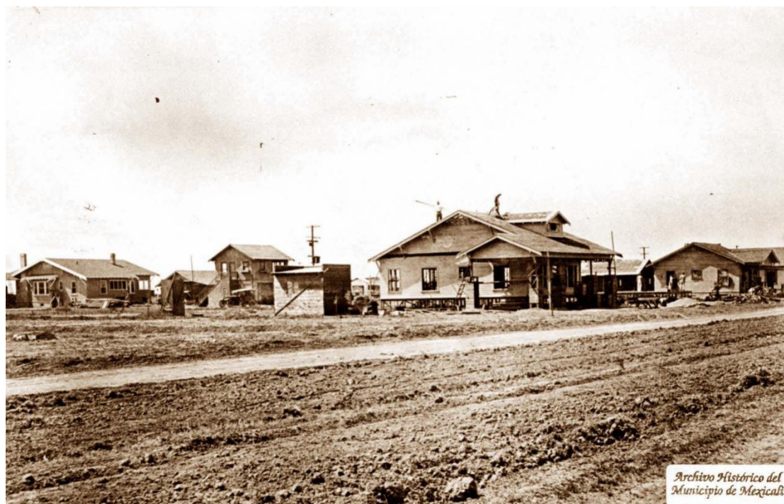
Ilustración 17 Construcción de casas estilo Bungalow.
