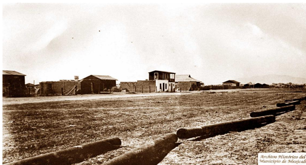
Ilustración 19 Colocación de tuberías, sección segunda. Archivo Histórico Municipal de Mexicali.
