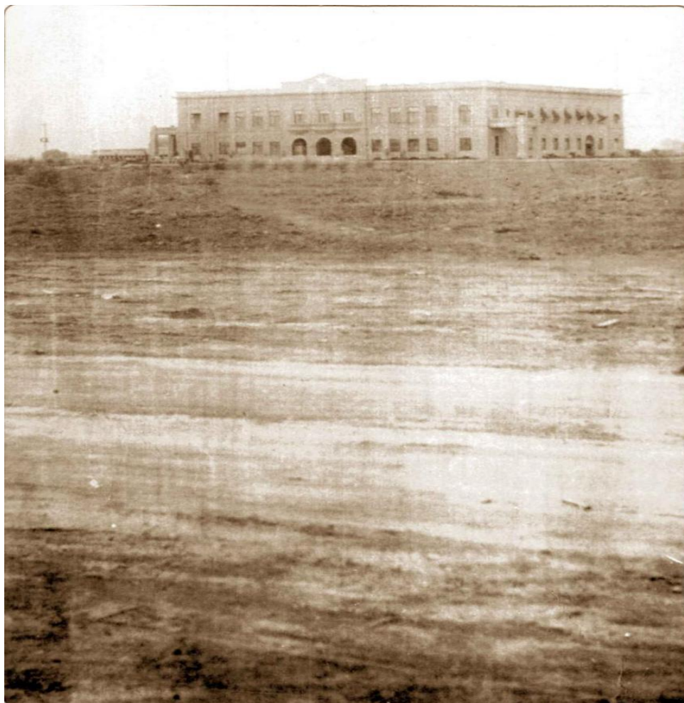
Ilustración 9 Palacio de Gobierno del Distrito Norte, Recién construido. Archivo Histórico de Baja California.
