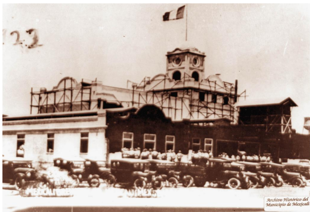
Ilustración 24 Imagen 11 construcción de la Cervecería de Mexicali de 1922, desde la parte trasera de la fachada principal. Archivo Histórico Municipal de Mexicali
