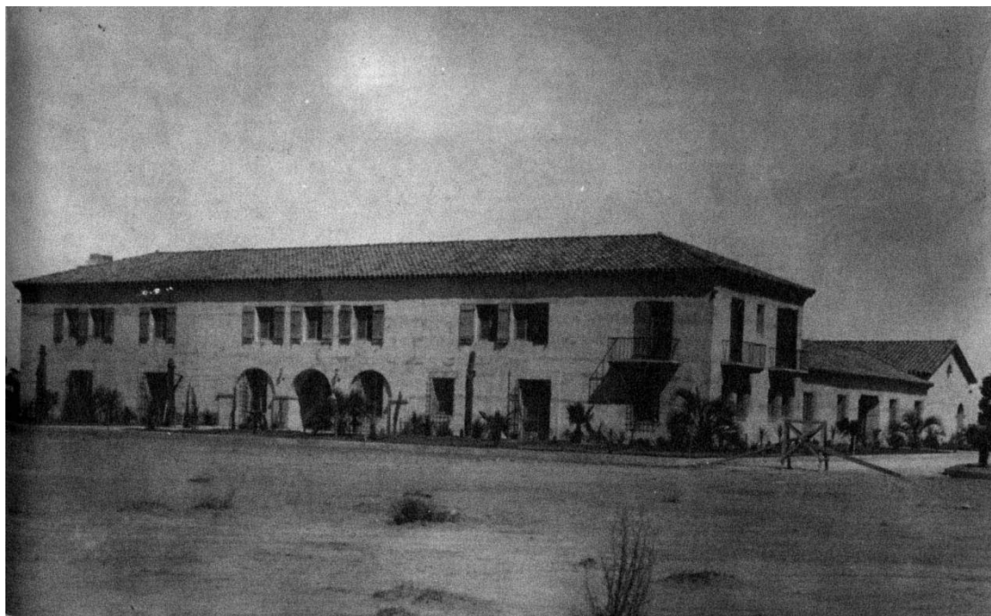
Ilustración 22. Edificio de la Colorado River Land Company, Tomado del Archivo Histórico Municipal.
