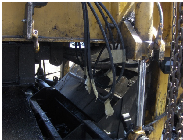
Banda transportadora que recoge la mezcla
