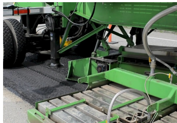
Entrada de banda transportadora para recuperar el asfalto
