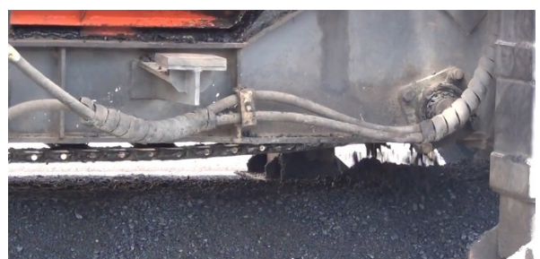
Aporte del nuevo asfalto a bulto de asfalto recuperado
