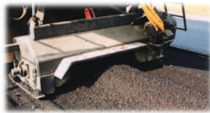
Figura 44. Máquina recogiendo el bulto de asfalto recuperado (Martec, 2018)
