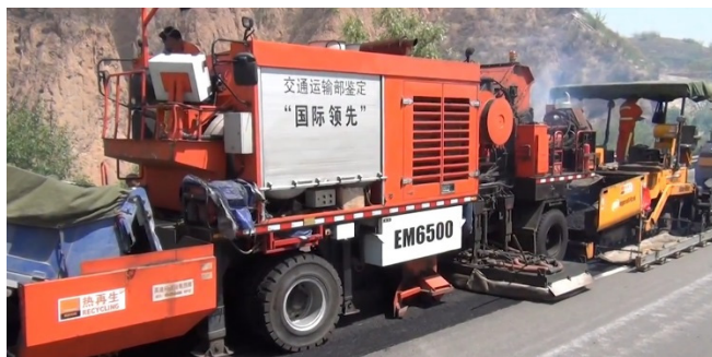
Recolector de asfalto recuperado y nuevo
