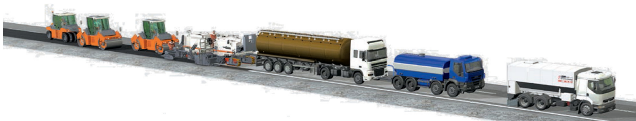
Figura 22. Proceso en frío con la máquina WR4200 de la máquina Wirtgen
