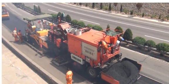
Recolector de asfalto recuperado y nuevo asfalto
