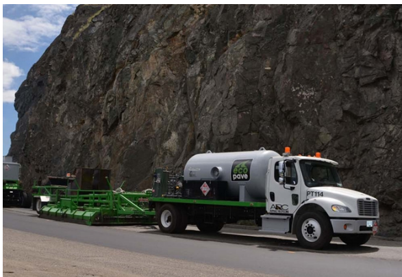
Estructura de pre calentador y troque
