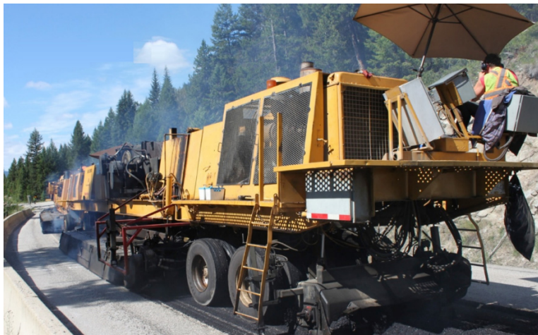
Figura 41. Pre calentador/fresadora AR2000
