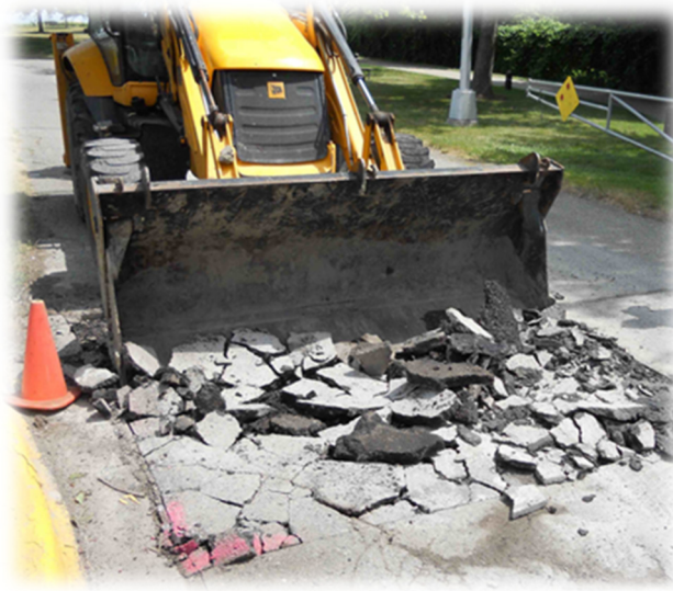
Figura 10. Demolición completa de la carpeta asfáltica
