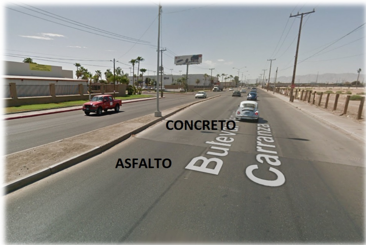
Figura 3. Bulevar Venustiano Carranza donde aplicaron una carpeta de concreto y asfalto
