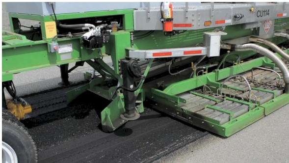
Entrada del bulto de asfalto a la banda transportadora
