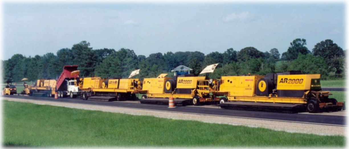
Figura 33. AR2000 durante una obra de mantenimiento (Martec, 2010)
