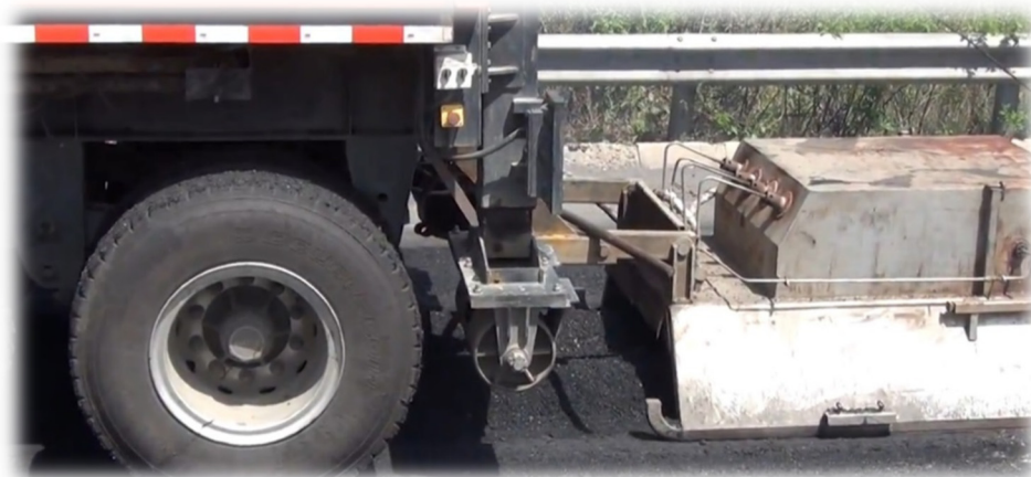
Figura 59. Formador del bulto y calentador a la salida del RM680 (Freetech, 2014)
