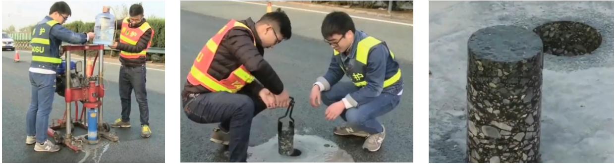
Figura 69. Toma de muestras asfálticas para verificar las condiciones y propiedades del material (Public Service Excellence, 2018)
