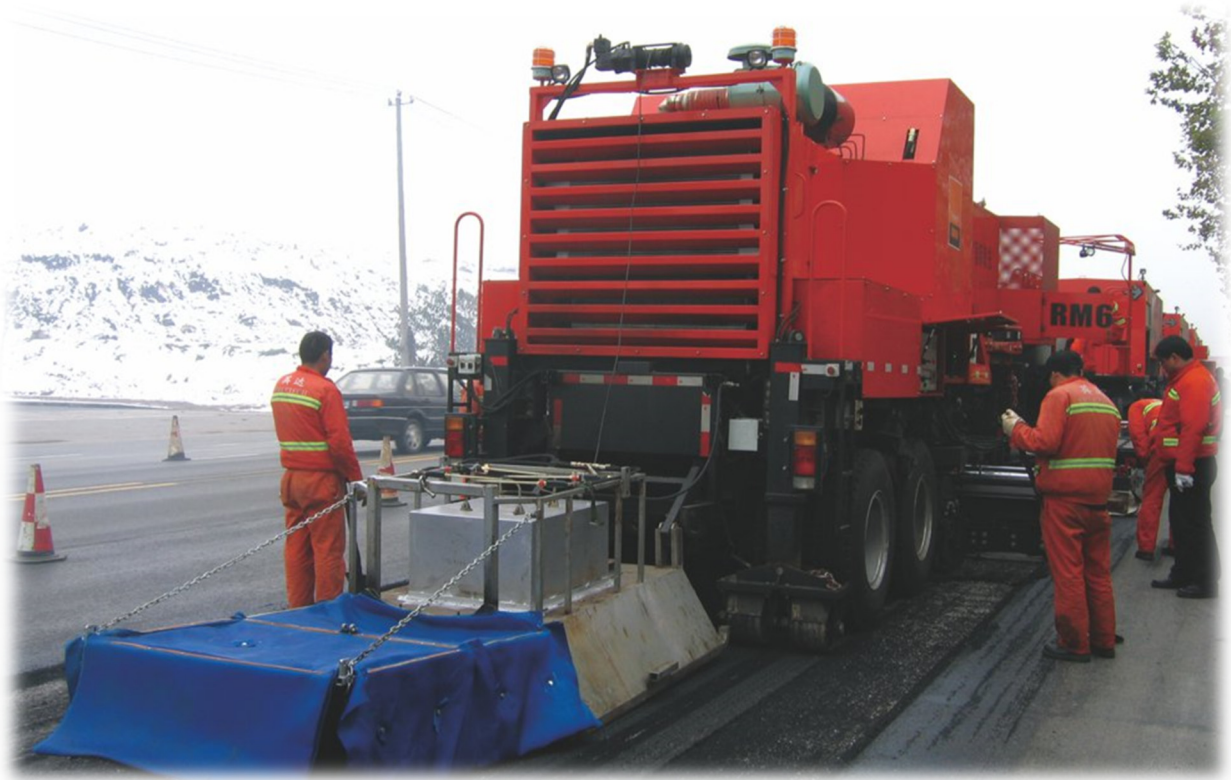
Figura 65. Freetech realizando una obra bajo temperaturas muy frías con éxito (Highways Today, 2017)
