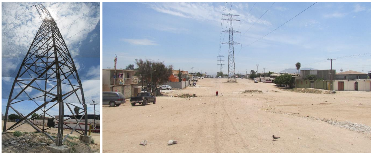
Figura 112. Torres de Alta tensión. (Las Torres Norte)
