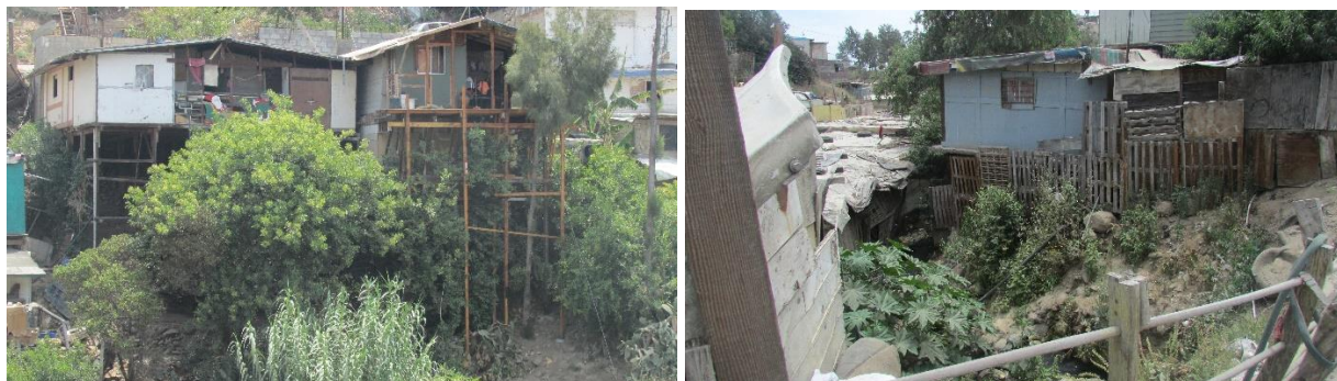
Figura 118. Características de la vivienda precaria en el sitio de intervención. (Las Torres Norte)
