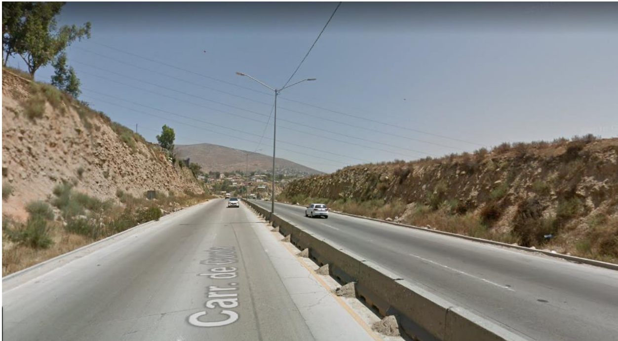
Figura 74. Condiciones del sitio a intervenir. (Carretera Cuota Tijuana-Tecate)
