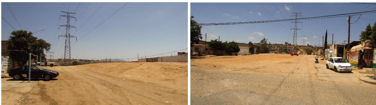
Figura 127. Infraestructura calle de las Torres, sur del sitio de intervención.
