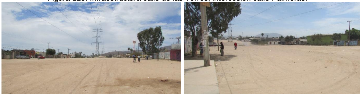
Figura 125. Infraestructura calle de las Torres, intercesión calle Palmeras.
