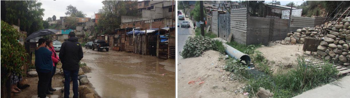
Figura 106. Situación de las bajadas pluviales naturales (Colonia las Torres)
