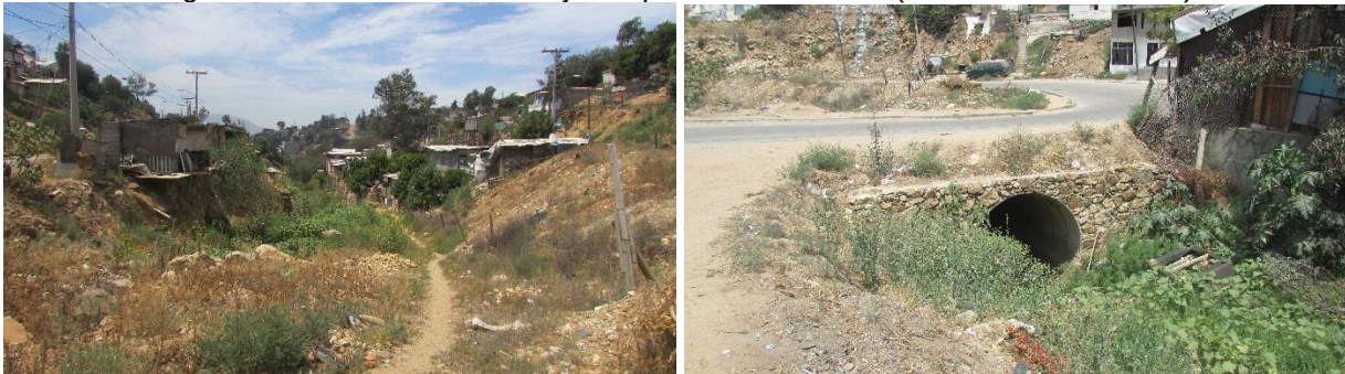
Figura 107. Situación de las bajadas pluviales naturales (Colonia la Rinconada)
