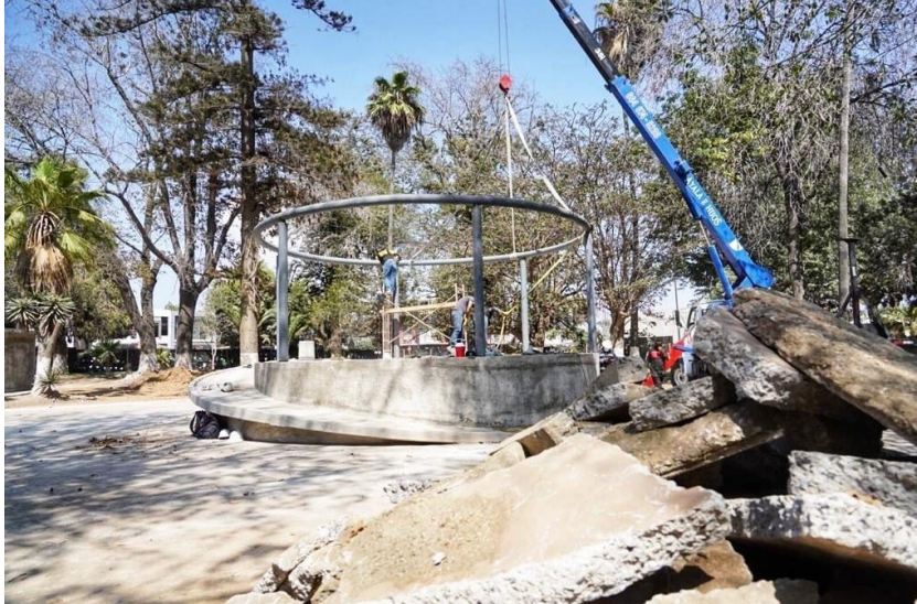
Imagen 69. Demolición del quiosco antiguo del Parque Revolución.
