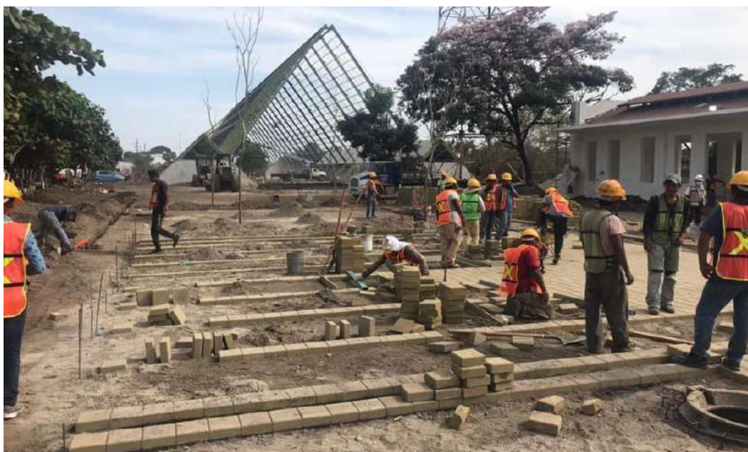
Foto 39: mano de obra inmigrante en la construcción de la nueva estación ferroviaria de Tapachula. Fuente: archivo personal Alberto Fong 2021.
