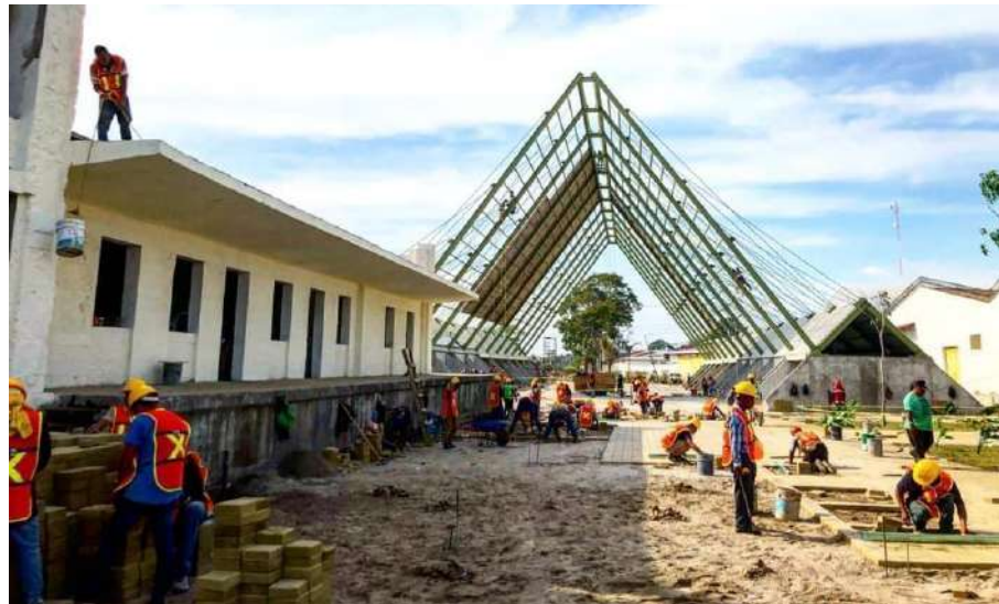
Foto 47: Construcción nueva Estación Cultural de Tapachula y su fuerza laboral multicultural. Fuente: archivo personal.
