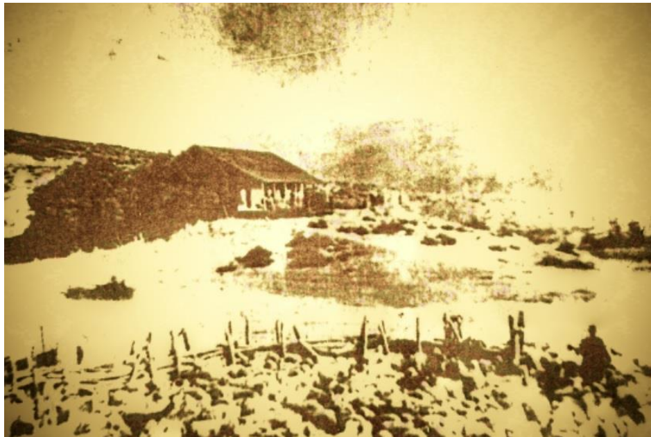
Figura 8. Fotografía del Archivo INAH (Fecha desconocida) donde se nota un poco de la arquitectura de la casa así como el entorno en que se encuentra ubicada. Nótese las pilastras en la fachada principal ( Sección Sur ). Tomado de Ortega (2015b).
