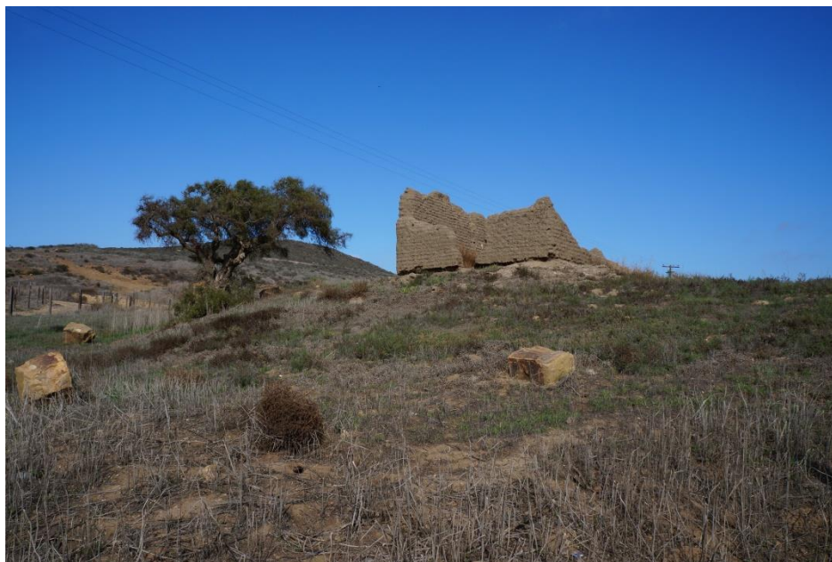
Figura 23. Fotografía de la Sección Sur de la Casa Machado del año 2014. El deterioro es notorio, además de ya haberse derrumbado la Sección Norte sólo quedaba en pie la mayor parte del muro central. Fotografía del Archivo Chávez.
