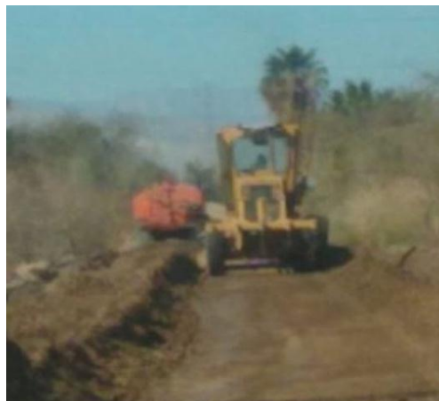
Figura 9 Preparación para la pavimentación en El Colorado Uno
