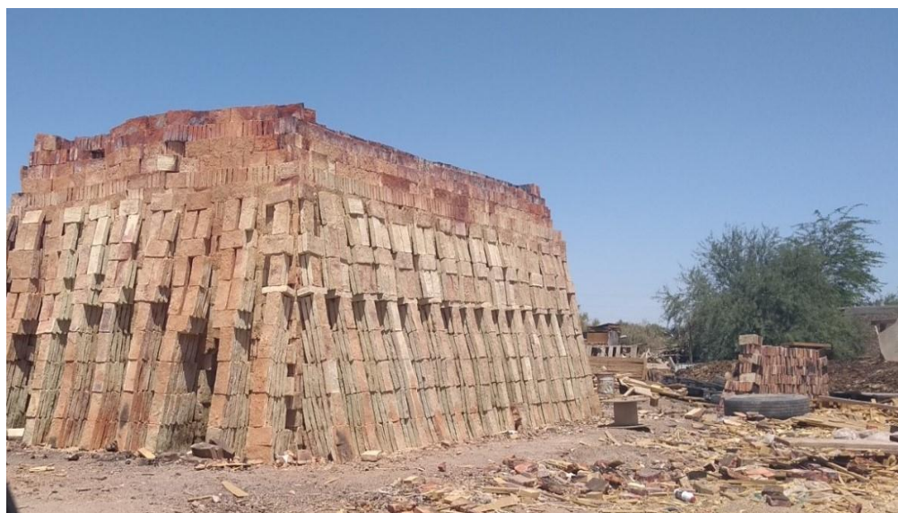
Figura 8 Ladrillos artesanales fabricados en El Colorado Uno
