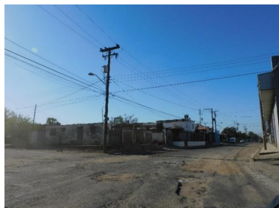
Figura 52. Intersección C. Bernardo Reyes y Av. industriales, rampas peatonales inexistentes, vialidad y banqueta en condiciones deplorables. (Ruiz, 2021)
