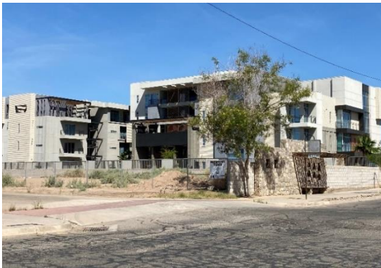
Figura 66. Vista desde el Sur, Departamentos Vivalta, a un lado de residencial cerrada del sol. (Ruiz, 2021)
