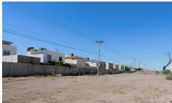
Figura 82. Dren tapado, barda perimetral de residencial Casa Maya II. (Ruiz, 2021).
