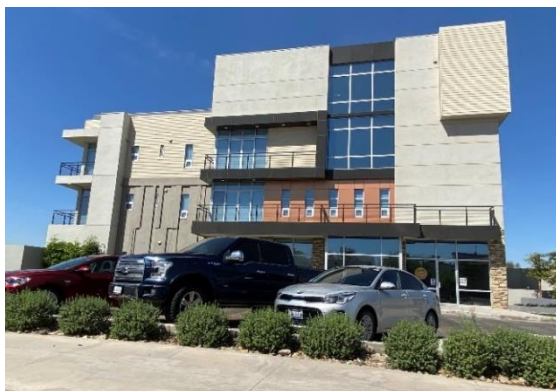
Figura 68. Vista desde el Este Departamentos Vivalta, a un lado de residencial cerrada del sol. (Ruiz, 2021)
