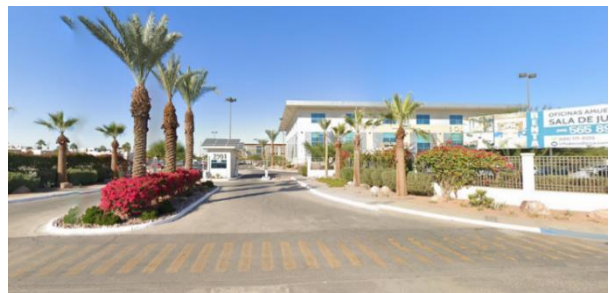
Figura 46. Edificio de oficinas Solarium sobre vialidad Calzada Cetys Imagen satelital Google maps, 2020.
