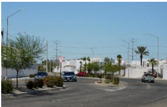
Figura 38. Vialidad C Bernardo Reyes, entrada a la izquierda y derecha fracc. Reserva Residencial Poniente, sentido hacia línea fronteriza y col. Flores Magón. (Ruiz, 2020)
