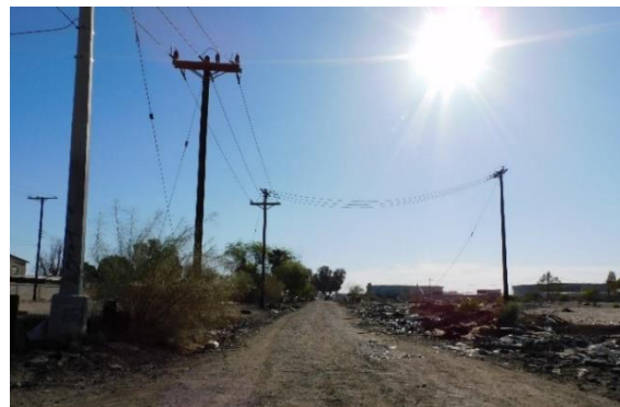
Figura 55. Avenida Corregidora Sur, viendo hacia el Este, calle sin pavimentar, (izquierda) colonia habitacional (derecha) baldío con basura. (Ruiz, 2021)
