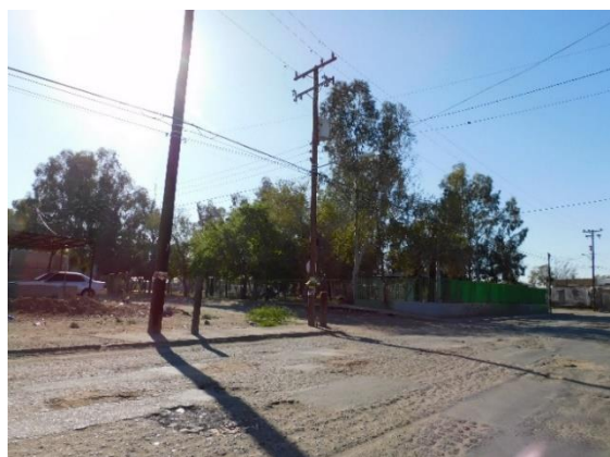
Figura 53. Intersección C. Bernardo Reyes y Av. Colonos, rampas peatonales inexistentes, vialidad y banqueta en condiciones deplorables. Parque público. (Ruiz, 2021)
