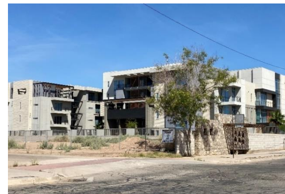
Figura 69. Vista desde el Sur, Departamentos Vivalta, a un lado de residencial cerrada del sol. (Ruiz, 2021)
