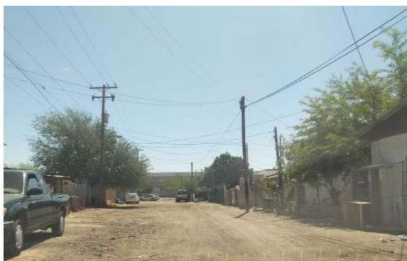
Figura 40. Calle Forrajeros, vialidad sin pavimentar dentro de colonia Flores Magón. (Ruiz, 2020)
