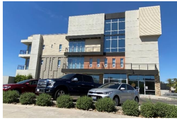
Figura 65. Vista desde el Este Departamentos Vivalta, a un lado de residencial cerrada del sol. (Ruiz, 2021)
