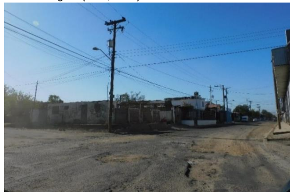
Figura 41. Intersección C. Bernardo Reyes y Av. industriales, rampas peatonales inexistentes, vialidad y banquetas en condiciones deplorables. (Ruiz, 2021)
