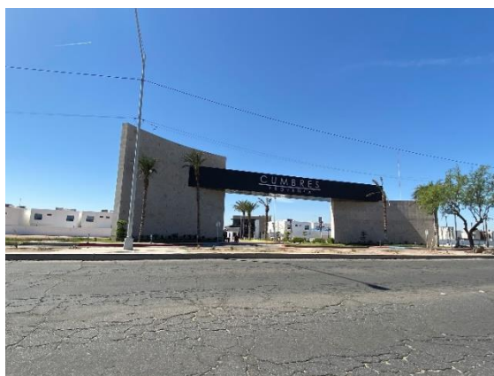
Figura 94. Acceso de residencial Cumbres, sobre calzada Cetys. (Ruiz, 2021)
