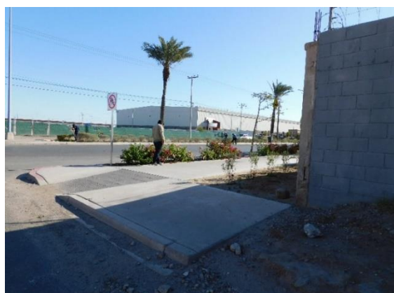
Figura 50. Intersección vialidad Melchor Ocampo y Av. Brasil, interrupción de banqueta y áreas verdes destinados a parques industriales, al fondo personal de mantenimiento, en banqueta peatón. (Ruiz, 2021)
