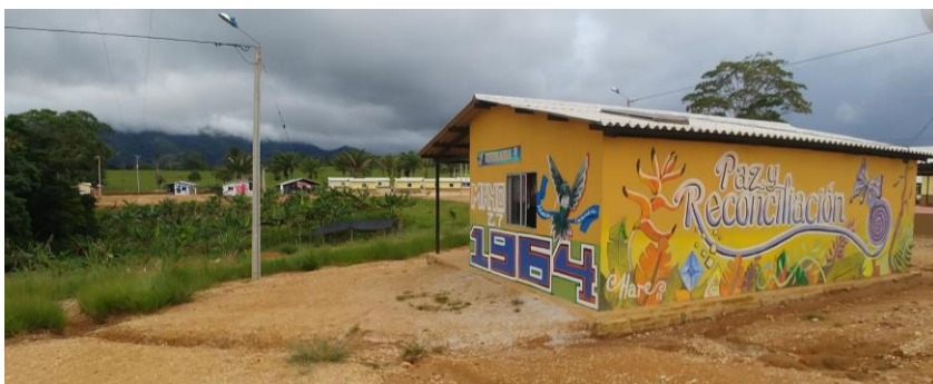
Imagen 6. Espacios, viviendas en construcción ETCR Agua Bonita.
