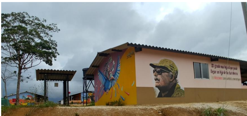
Imagen 5. Vivienda en construcción ETCR Agua Bonita, Caquetá
