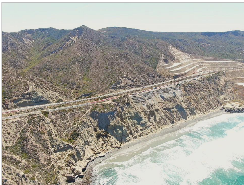
Figura 2.3. Socavación y erosión marina en taludes escarpados del kilómetro 92+500-700 de la carretera escénica Tijuana – Ensenada, (Pelayo C., 2022).
