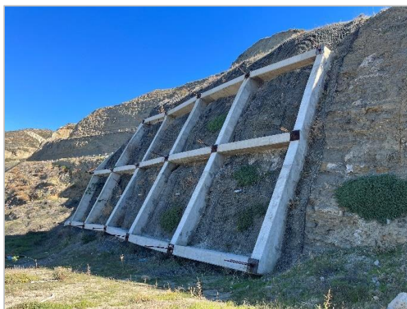
Figura 7.4. Anclas de sujeción en talud de kilómetro 91+450, durante la tercera visita.
