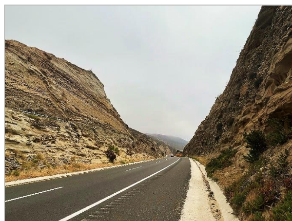
Figura 7.8. Taludes en el kilómetro 92+100 (vista desde cuerpo A), durante la séptima visita.
