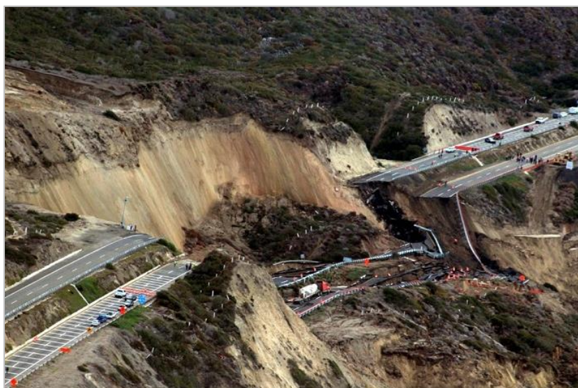
Figura 1.2. Derrumbe km 93+000, diciembre de 2013, (Fernández, 2014).
