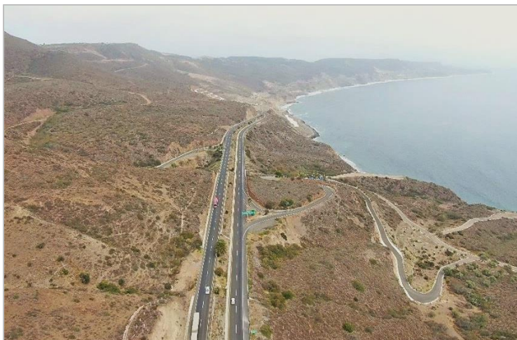
Figura 1.1. Vista en Dron de la carretera escénica Tijuana – Ensenada, a la altura del kilómetro 87+700, (Pelayo C., 2022).
