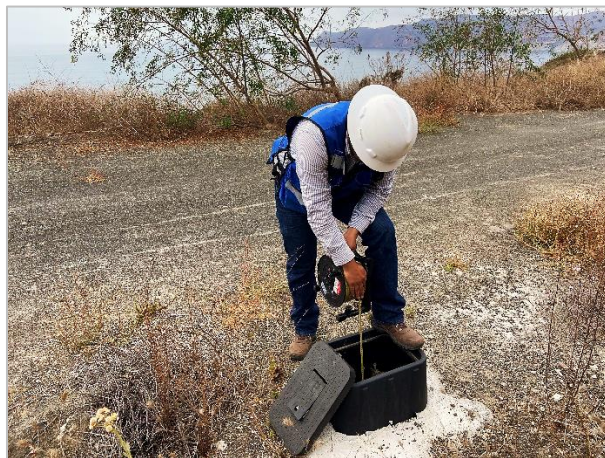
Figura 7.7. Medición del tubo de observación 02 del kilómetro 93+500 (cuerpo B, sobre camino rural), durante la sexta visita.
