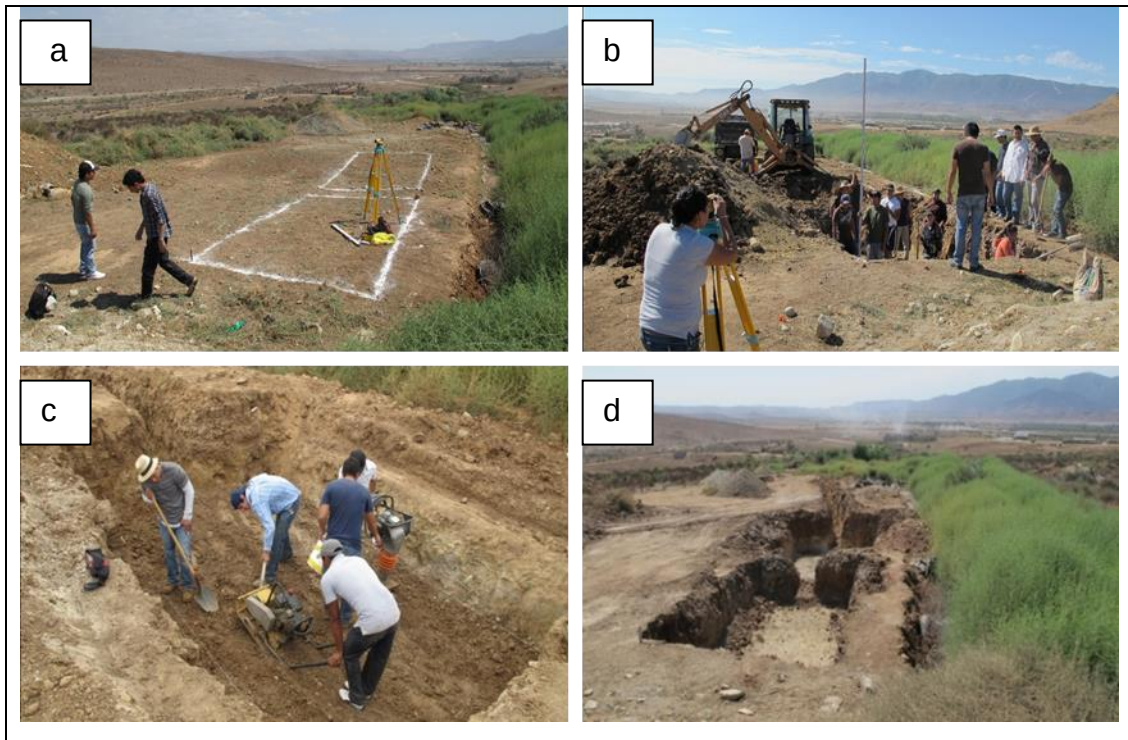
Figura 4.3 Trabajos preliminares de Limpieza, trazo y nivelación (a), Excavación (b), compactación y afine (c y d)
