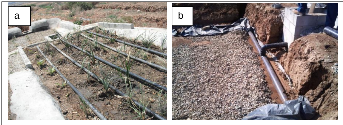
Figura 4.7 Colocación de la red de alimentación en el filtro vertical (a) y filtro horizontal (b)
